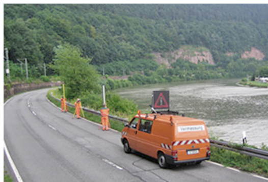
Abb. 5: Nivellementtrupp direkt vor einem Sicherungsfahrzeug
