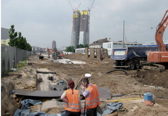
Abb. 2: NRM, Frankfurt, Ostend-Sanierung, spartenübergreifende Medienverlegung (2012)
