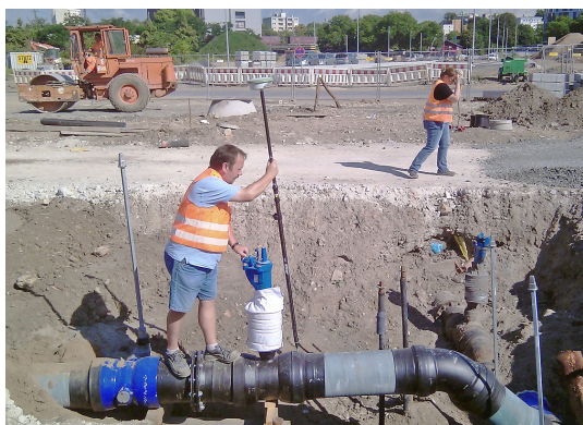
Abb. 5: NRM, Frankfurt, Ostendsanierung, Sparte Wasser, Leitungsaufmaß (2012)
