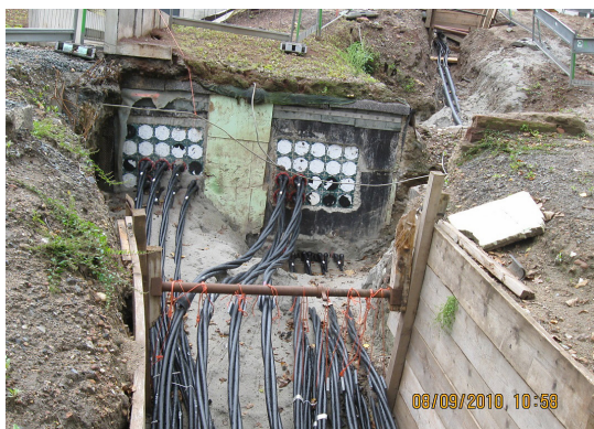
Abb. 1: NRM, Einführung Frankfurt Umspannwerk Hochstraße im Bau (2010)
