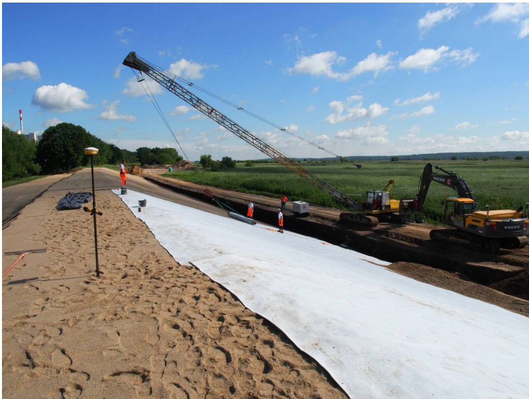
Abb. 3: Verlegung von Geosynthetischen Tondichtungsbahnen. Das Betreten der Überlappungsbereiche ist nicht zulässig. Die erste Schutzschicht muss unmittelbar nach der Verlegung aufgebracht werden. Oderdeich, Polder 10 bei Schwedt, Baulos 63, Foto: Blüher
