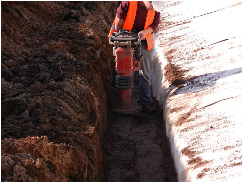
Abb. 4: Einbau einer GTD. Verdichtung des Einbindegrabens am Deichfuß.
