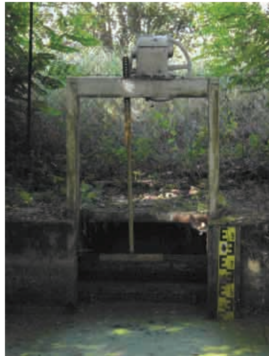
Bild 2.26: Festes Staubauwerk am Abflussgraben des Byhleguhrer Sees (L. LANDGRAF 08/03)
