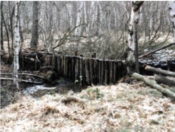
Bild 2.63: Von Schülerarbeitsgruppen errichteter Stau (Kastenfangedamm) (N. LACHMANN 01/94)
