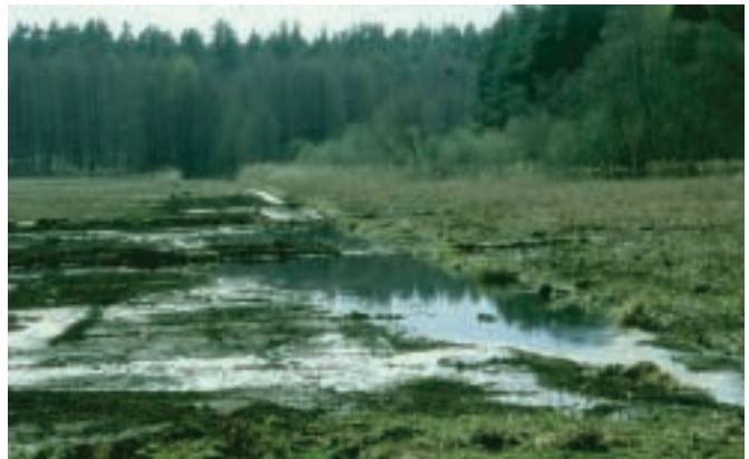
Bild 1.4.9: Degradierter Oberboden eines Durchströmungsmoores wird abgeschoben und zur Verfüllung des Hauptgrabens verwendet (R. MAUERSBERGER)
