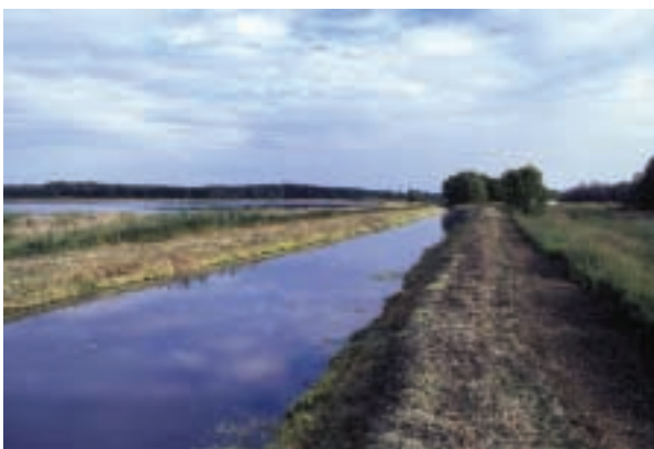
Bild 1.4.1: Pfefferfließ – ein ausgebautes, ehemals natürliches Fließgewässer nach Grundräumung und Böschungsmahd (L. LANDGRAF 1997)
