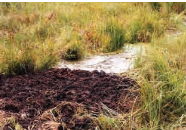
Bild 2.32: Partielle Grabenverfüllung mit hochgesetzten Torfen (W. ARP 09/01)
