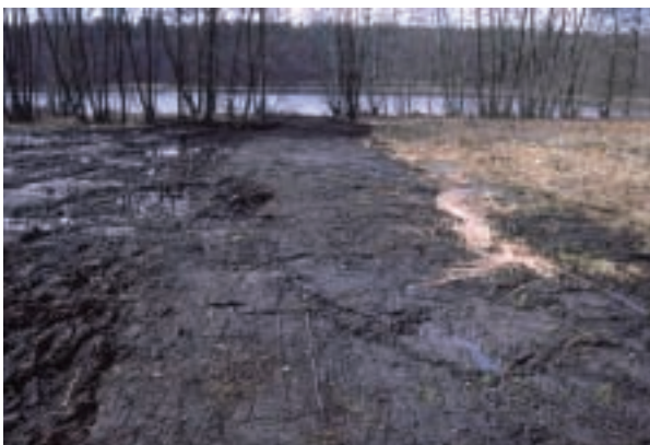
Bild 1.4.7: Um bei der Grabenverfüllung mit Torfmaterial eine erneute Gerinnebildung zu vermeiden, sollte nach der Verdichtung eine bis 50 cm erhabene Füllung angelegt werden (R. MAUERSBERGER)
