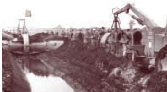
Bild 1.3.3: Leistungsfähige Technik, wie der von Seilzugaggregaten gezogene Grabenpflug, machte in den 1960er und 1970er Jahren großflächige Tiefentwässerungen in Mooren möglich (Quelle: Brandenburgisches Landeshauptarchiv Rep 550 Nr. 51)
