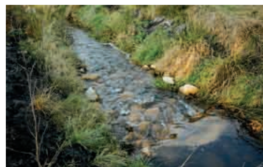
Bild 2.10: Riembach mit eingebauter Sohlgleite (U. ALEX)
