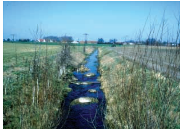
Bild 2.55: Künstlich ausgebautes Regelprofil mit neu angelegter Sohlgleite südlich der Ortschaft Demnitz (J. GELBRECHT 2001)
