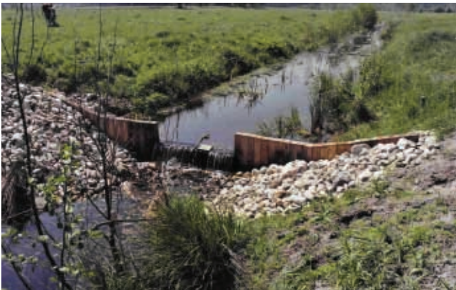
Bild 2.45: Sohlschwelle in der Quellregion des Pfeffergrabens, für einen Probelauf so gestaltet, dass eine maximal verträgliche Höhe mit dem Bewirtschafteter abgestimmt und festgesetzt werden kann (L. LANDGRAF 2002)
