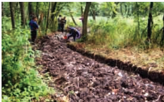
Bild 2.4: Per Hand ausgeführte Aushubarbeiten an einem Altmäander (K. LIESKE 2002)
