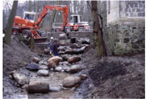
Bild 2.17: Sohlenrampe Pritzhagener Mühle im Bau, mit um 10 cm abgestuften Steinschwellen zur Sicherung ausreichender Fließtiefen auch bei geringen Abflüssen (F. KRÜGER, Herbst 1994)
