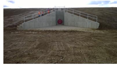
Bild 1 – 3: Deichbau mit Überlaufschwelle in den Polder und Sielbauwerk
