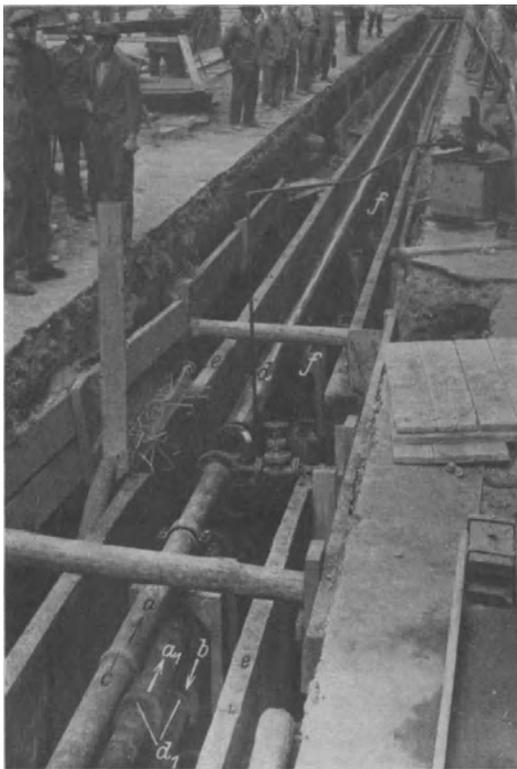
Abb. 29. Heizkanal Städteheizwerk Dresden (Bauzustand: Druckprobe). *a a*<sub>1</sub> Heißwasservorläufe (s. Abb. 17), *b* Rücklaufleitung (3 Leitungen übereinander zwecks Platzersparnis), *c* Schweißmuffen als Verbindung, *d* Trockenstopfisolierung (Gichtstaub) im Blechmantel (Ausführung Fa. Bohle, Köln), *e*, Abstützringe für Blechmantel, *e* fabrikfertige Seitenwandplatten vertikal verfugt und vergossen, *f* gemeinsames Auflager für 3 Leitungen.
