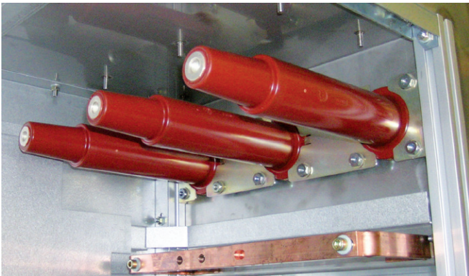
Abb. 7.5.1: Blick in den Kabelanschlussbereich mit Außenkonus Anslusstyp C unter Luft ohne Kabelanschluss (während der Werkmontage ohne Kabelanschlussraum)
