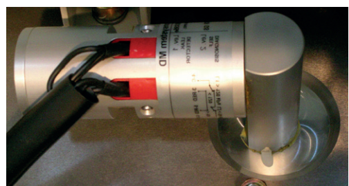
Abb. 7.12.3: Meldeleuchte für Gasdichte (Verwendung, wenn die Meldung nicht im Schutzgerät integriert ist)
