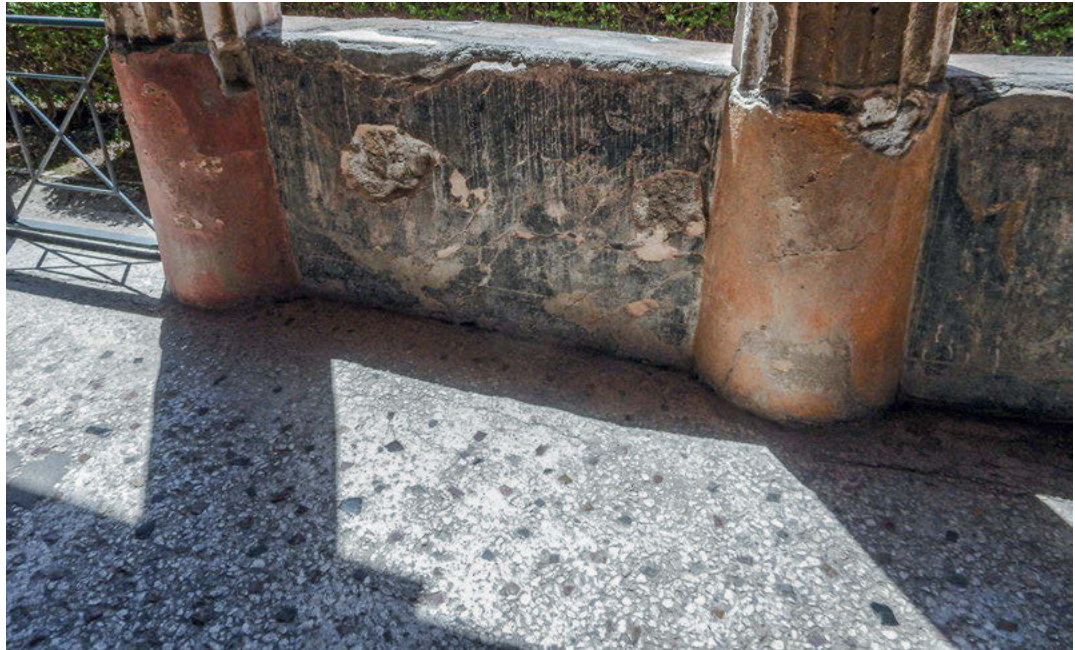
Abb. 246: Bodenbelag des Peristyls der Casa del Menandro (I 10,4).
