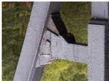
Abb. 12.12.: Schwalbenschwanz Zeichnung: NUTSCH (1996) Foto: Nis Nöhring
