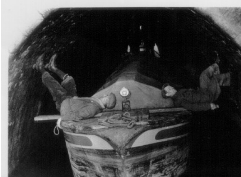
Abb. 14.4.: Im Harecastle Tunnel
