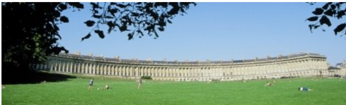
Abb. 15.6.: Der Royal Crescent mit Park Quelle: www.visitbath.co.uk
