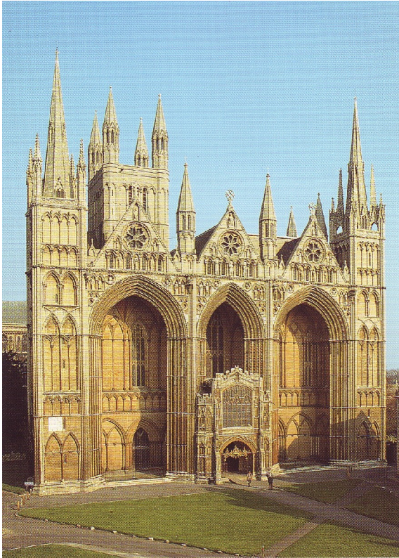
Abb. 11.8.: Beispiel für eine Westfassade im Early English Style: Peterborough (1118-1238)
