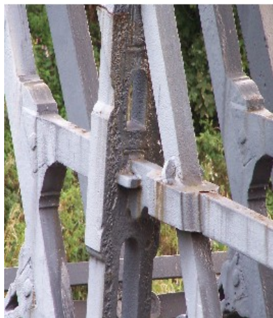
Abb. 12.11.: Gekeilte Verbindung Zeichnung und Foto: Nis Nöhring
