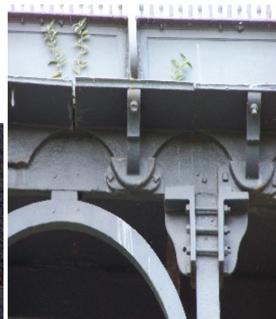
Abb. 12.13.: Schlitz und Zapfen Zeichnung: NUTSCH (1996) Foto: Nis Nöhring
