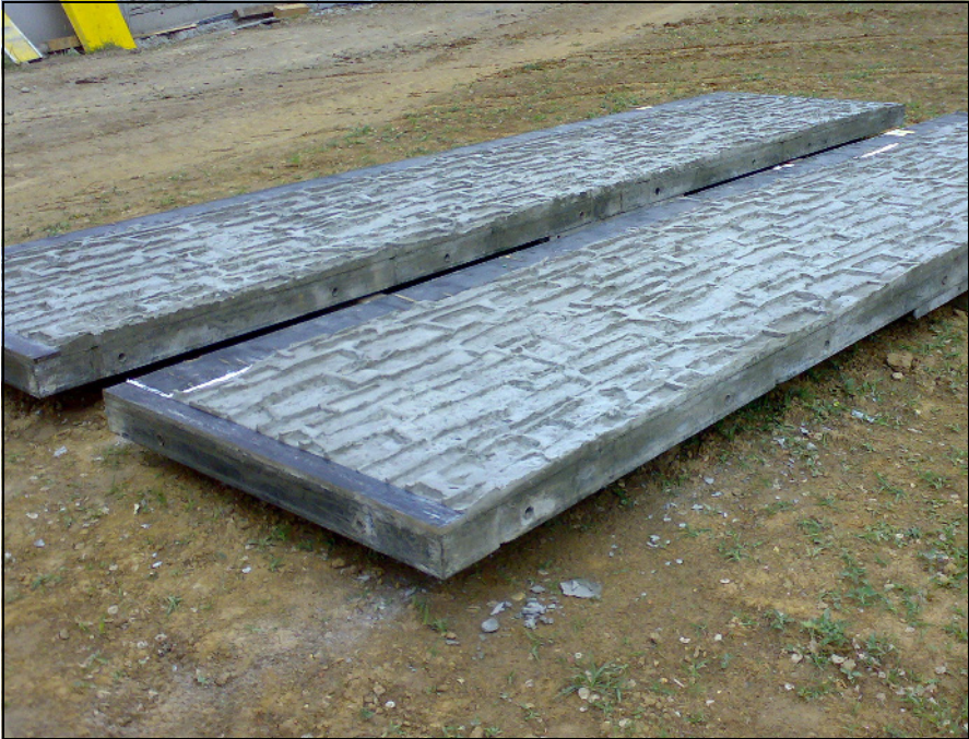
Abb. 4-8 Einsatz einer NOE Matrizenschalung für eine Gartenmauer [Foto: Hofstadler]
