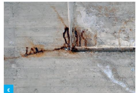
**d** Durch Abplatzungen sind hier bereits größere Teile der Armierung freigelegt.
