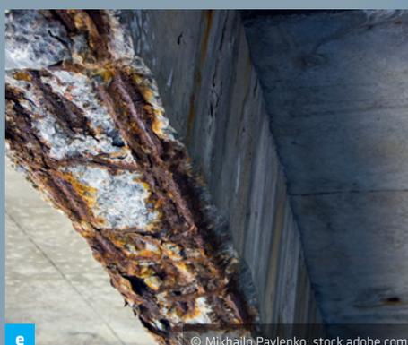
**f** Reste der Morandi-Brücke in Genua (IT). Der Viadukt stürzte am 14. August 2018 ein. Hauptursache waren stark korrodierte Betonstahlelemente in den betonummantelten Schrägverspannungen.
