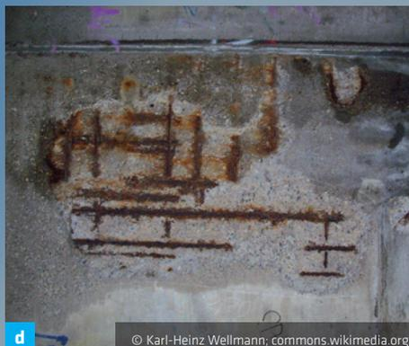
**e** Akuter Handlungsbedarf: Die freigelegten Armierungen sind hier durch die Korrosion bereits massiv angegriffen.
