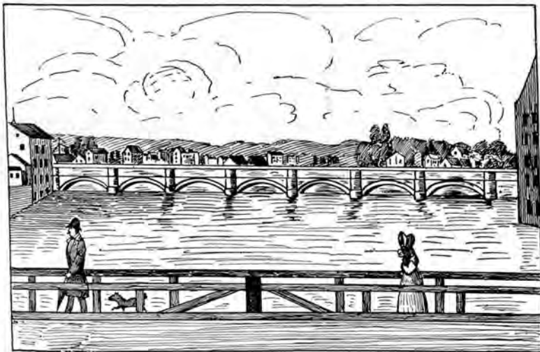
Geneseebrücke in der Buffalostrasse
