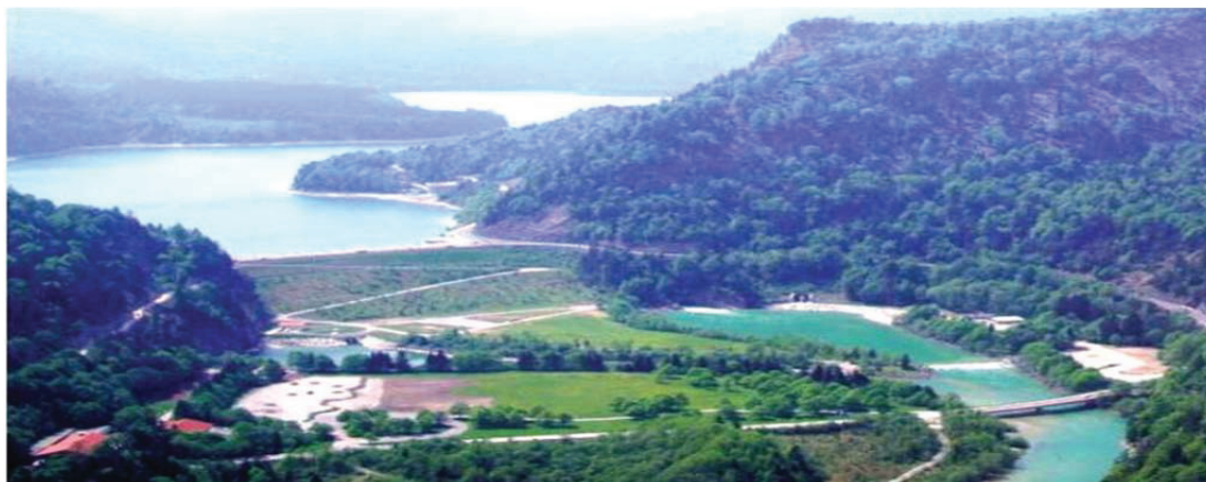
Abb. 2: Blick auf den Sylvenstein Staudamm
