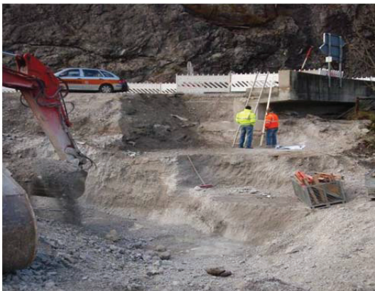
Abb. 6 und 7: Freilegung der Felsoberfläche am Hennenköpfl und Errichtung des Kopfbauwerkes vom Zielschacht
