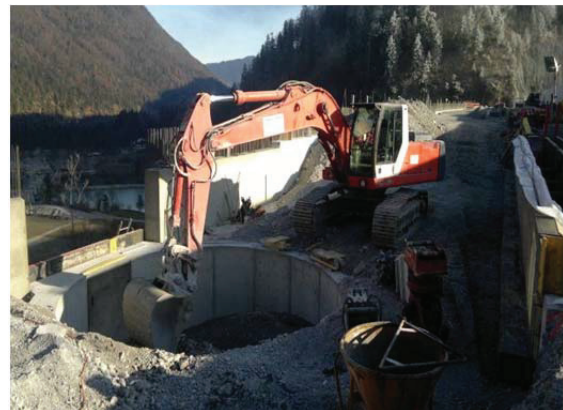
Abb. 6 und 7: Freilegung der Felsoberfläche am Hennenköpfl und Errichtung des Kopfbauwerkes vom Zielschacht
