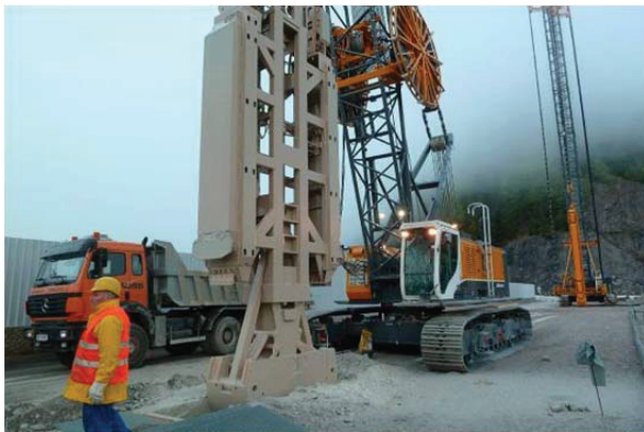
Abb. 10 und 11: Laufender 24 h Baubetrieb, Greifern und Fräsen des Schlitzes, der mit Stützsuspension gefüllt ist
