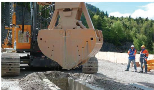
Abb. 8 und 9: Fräse und Greifer zur Herstellung der 70 m tiefen Dichtwand
