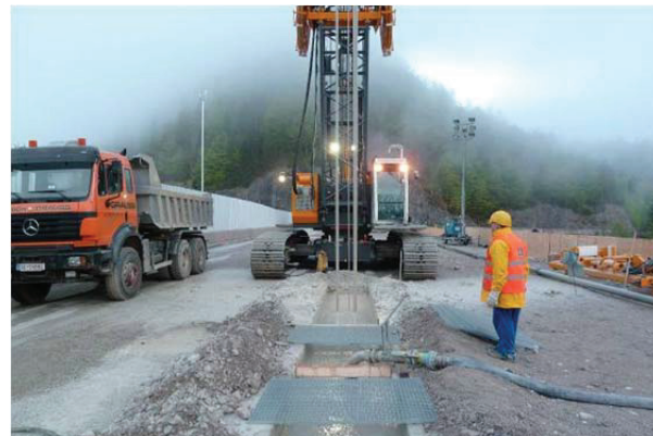
Abb. 10 und 11: Laufender 24 h Baubetrieb, Greifern und Fräsen des Schlitzes, der mit Stützsuspension gefüllt ist
