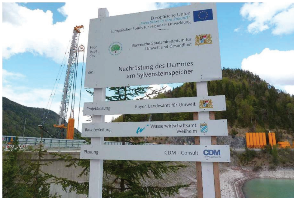
Abb.1: Bauschild zur laufenden Baumaßnahme zur Ertüchtigung des Sylvenstein Staudammes
