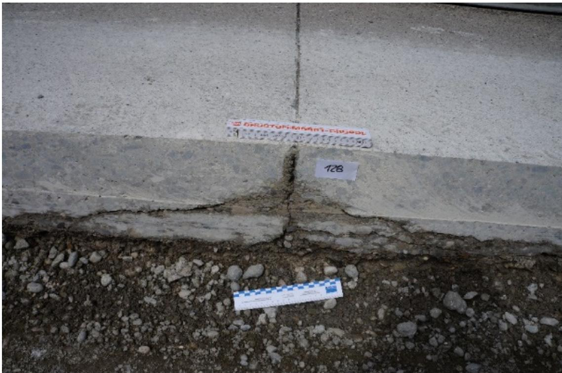
Abbildung 2.8: Keilförmige Risse im unteren Scheinfugenbereich [29]
