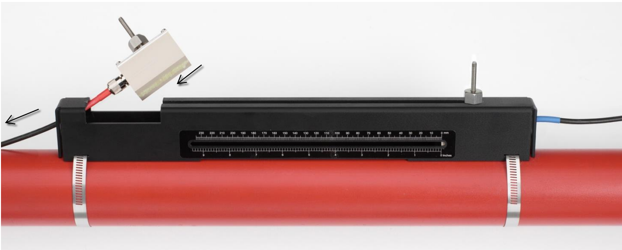
Abbildung 15 Installation des vorgelagerten Messwandlers (rot)
