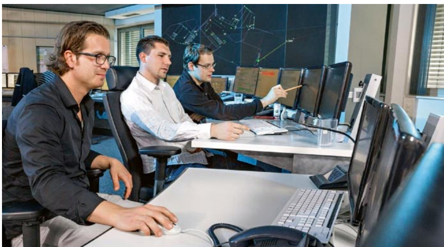
Fig. 9. Control room at Prosper-Haniel colliery Bild 9. Leitwarte auf dem Bergwerk Prosper-Haniel
