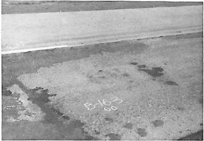
Bild 2 Im Herbst 1942 gebaute „Long-Time Study“-Versuchsstrecke bei New York (Allentown, N. Y., Route 17); hergestellt aus mäßig steifem Beton mit rd. 365 kg PZ/m 2 ; Wasserzementwert rd. 0,42. — Vordere Fahrbahn ohne LP-Zusatzmittel (Luftgehalt 0,5 %) durch Tausalze stark angegriffen; hintere Fahrbahn mit LP-Zement (Luftgehalt 4,1 %) ohne Veränderung (Foto PCA, Chicago)
