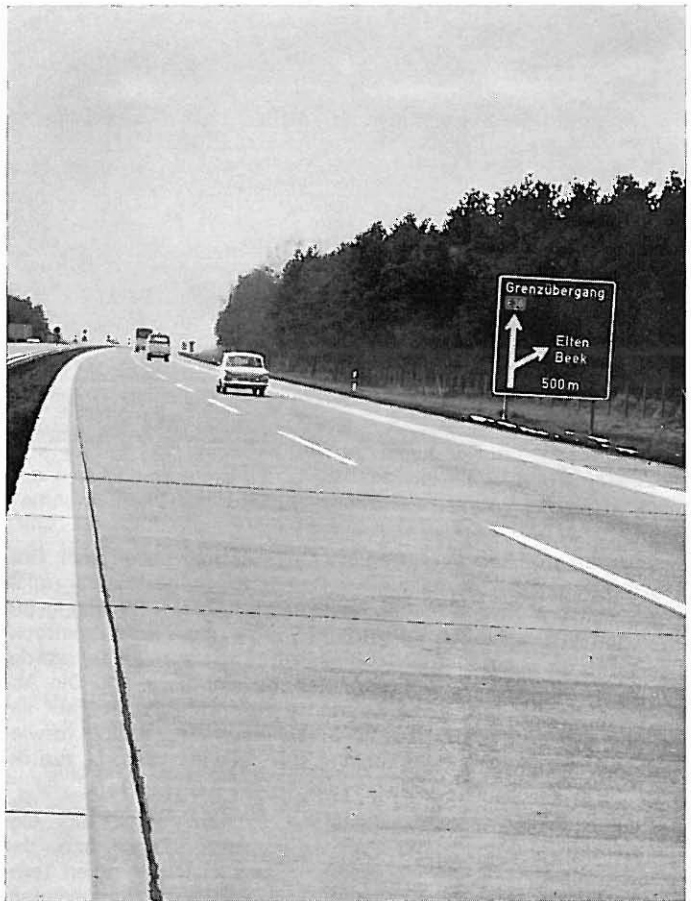
Bild 1 Betonstraße ohne Tausalzschäden
