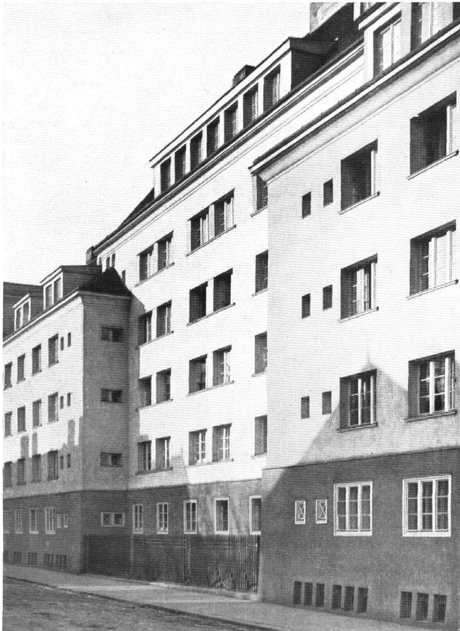
Abb. 35 / Fuchsenfeldhof. 2. Teil / Architekten: Schmid und Aichinger Teilansicht an der Murlingengasse (vgl. Abb. 10–14 und 28–29)
