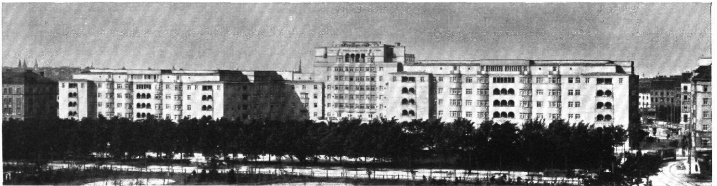
Abb. 34 / Gesamtansicht der Wohnhausgruppe Reumannhof
