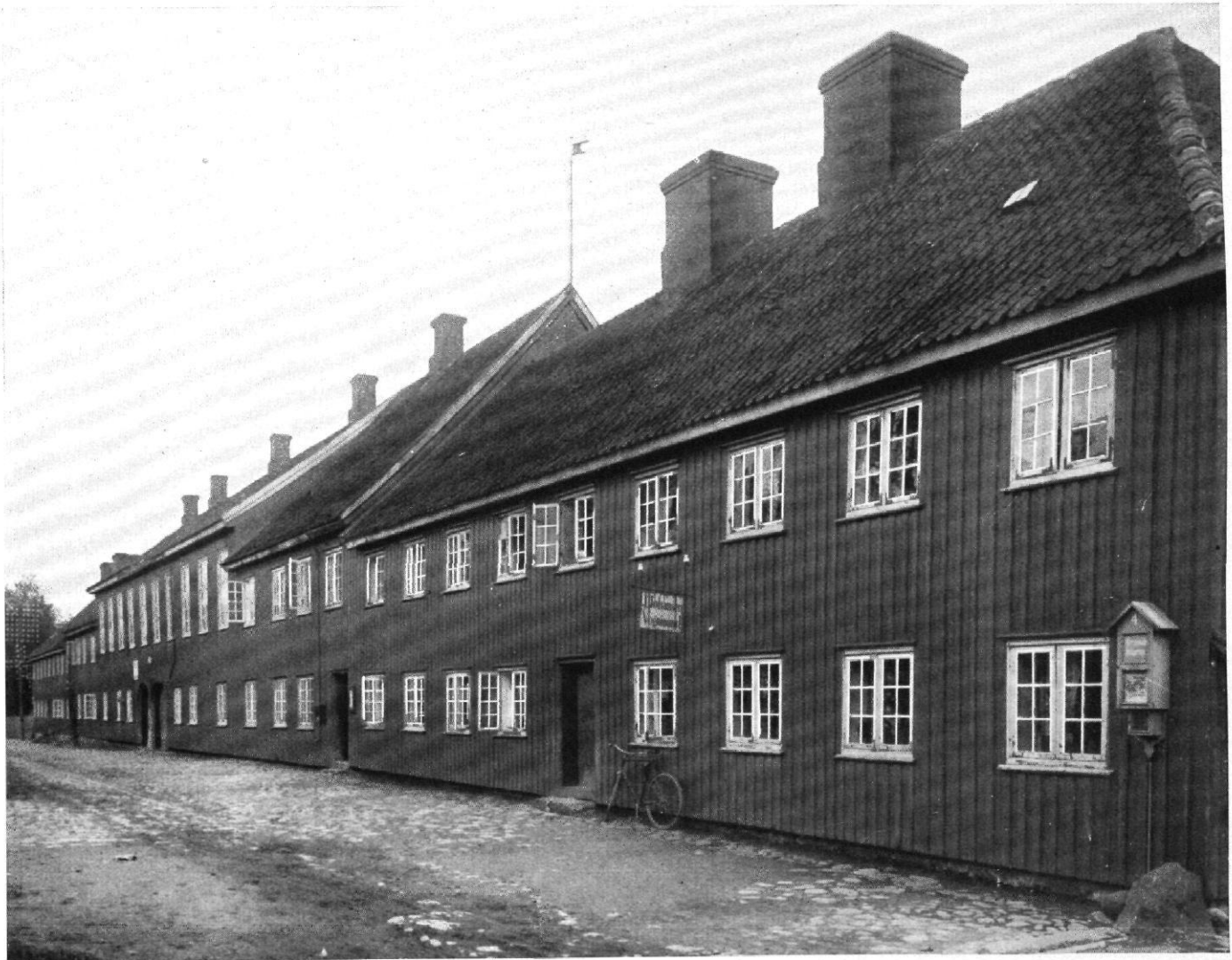
Abb. 2 / Fredriksværn / Holzhäuser der alten Flottenstation
