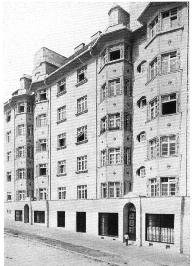
Abb. 9 / Metzleinstalerhof / 2. Bauabschnitt / Ansicht an der Fendgasse
