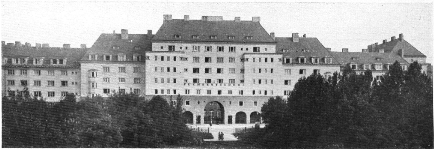
Abb. 10 / Fuchsenfeldhof / 2. Teil 1922/24 / Architekten: Schmid und Aichinger / Ansicht von der Neuwallgasse
