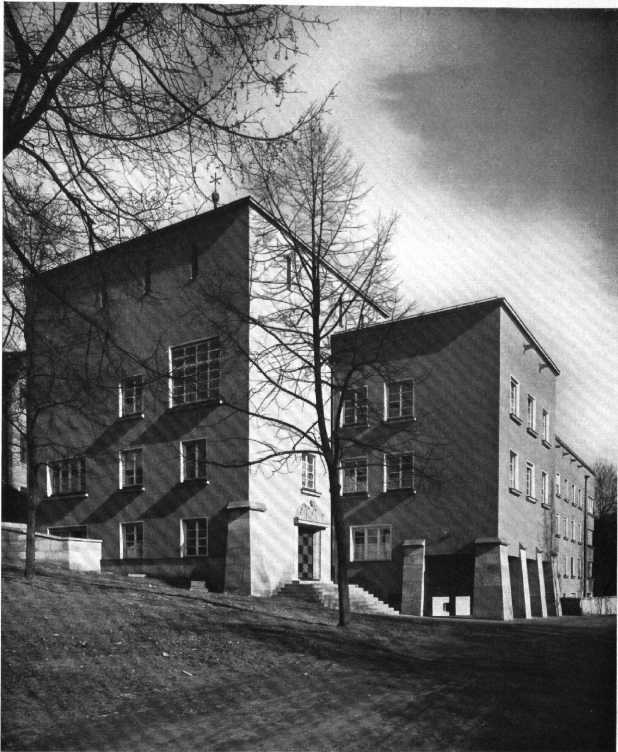
Abb. 9 / Krankenhaus Hallerwiese in Nürnberg / Architekt: German Bestelmeyer, München / Ansicht mit Haupteingang und Unterfahrt
