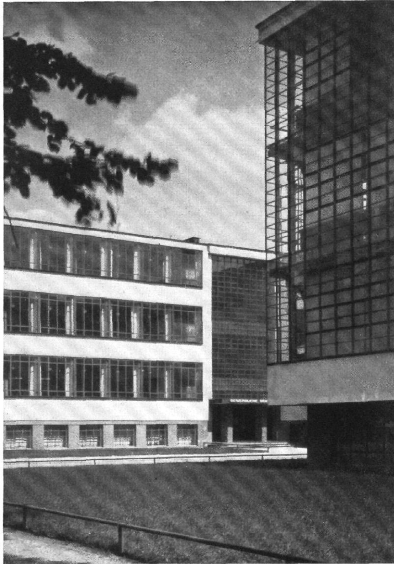
Abb. 9 / Bauhaus Dessau / Architekt: Walter Gropius Das Gebäude rechts ist ein Beweis dafür, daß der Grundsatz der einheitlichen Glasfelder bis zum Äußersten durchgeführt werden kann, wenn man nicht an die Hitze, Kälte und Geräusche im Hause zu denken braucht.
