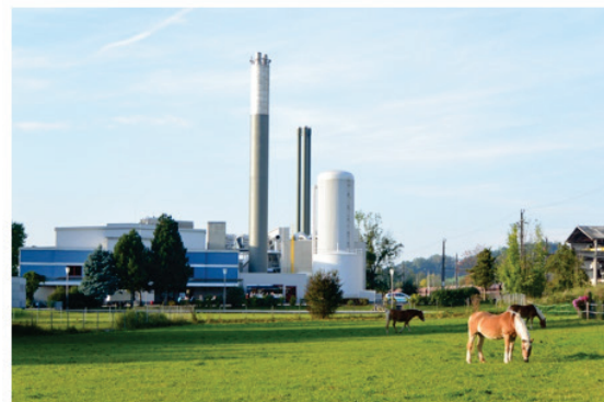
Abbildung 31: Heizwerk in Kirchdorf an der Krems. (Quelle: Energie AG OÖ Wärme GmbH)
