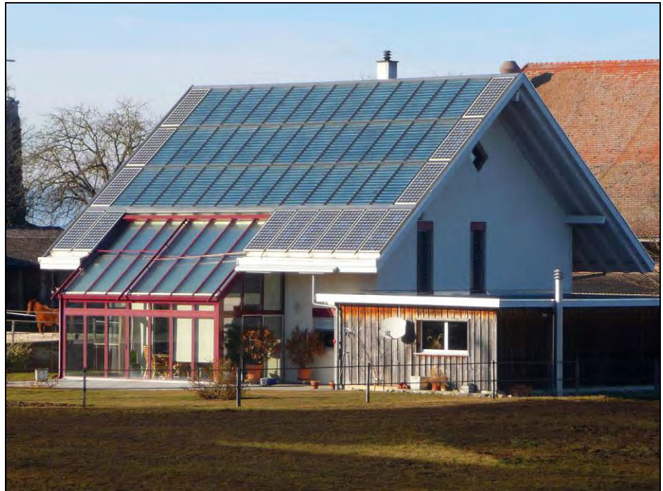
Abbildung 89: Das Sonnenhaus in Uttwil (Bösingen) wird schon seit über zehn Jahren 100% solar beheizt. Photo: M. Gutschner
