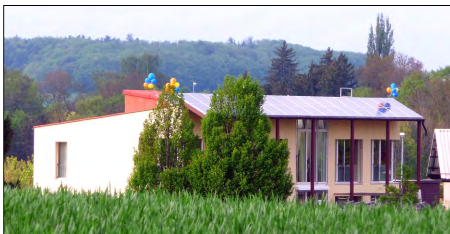
Abbildung 39: Das erste Minergie A und A-ECO Haus der Westschweiz steht in Jetschwil (Düdingen). Photo: M. Gutschner
