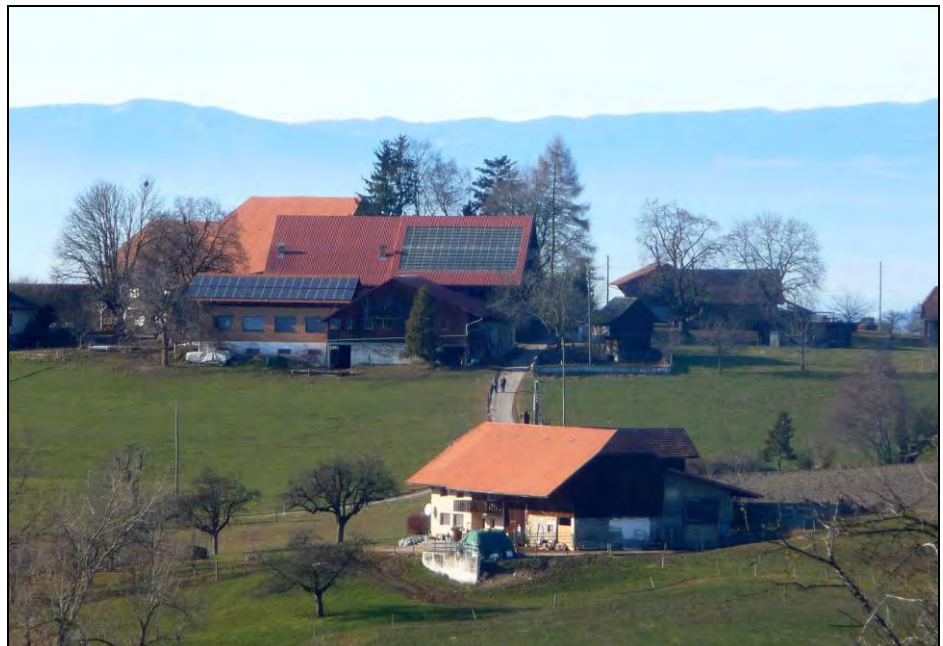
Abbildung 66: Die Photovoltaikanlage in Guglenberg (St. Antoni) gehört zu den allerersten Anlagen im Kanton Freiburg und speist seit den 1990er-Jahren Solarstrom ins Netz ein. Photo: M. Gutschner
