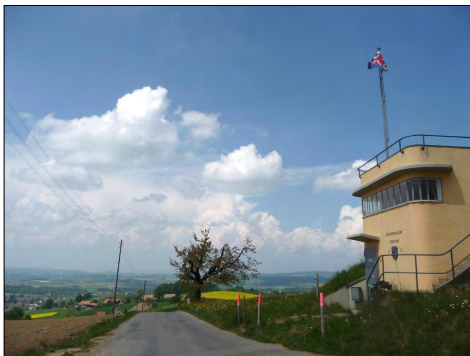
Abbildung 62: Die Wasserversorgung im Sensebezirk ist im schweizerischen Vergleich bei Wasser- und Energieverbrauch vergleichsweise effizient. Im Bild das Wasserreservoir der Wasserversorgung Ueberstorf auf der Höhi. Photo: M. Gutschner
