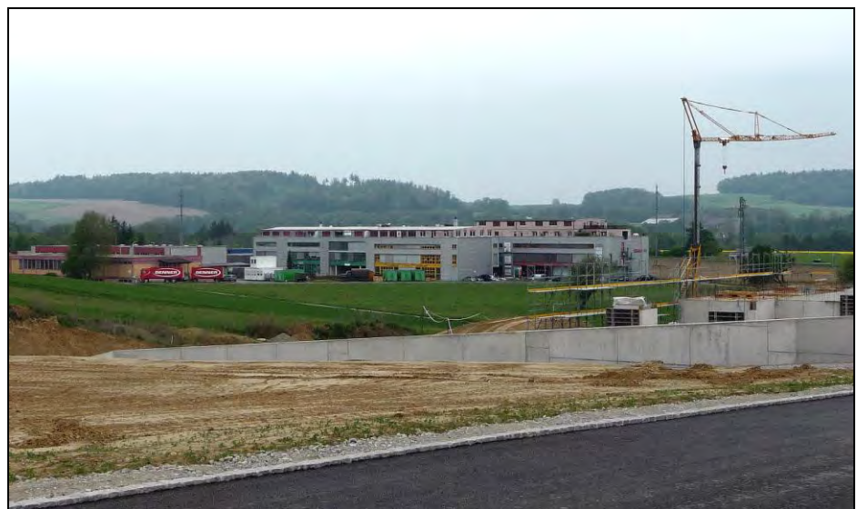
Abbildung 78: Die Industriezone in Düdingen ist für den Kanton und auch für die energetische Nutzung von strategischer Bedeutung. Im Bild die Arbeiten in der prioritären Erweiterungszone beim Autobahnanschluss. Photo: M. Gutschner
