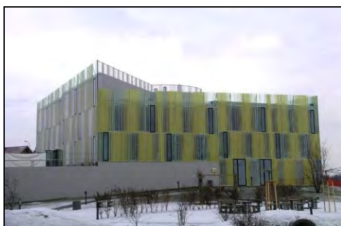
Schulgebäude (EBF 2'866 m 2 ) in Schmiten
