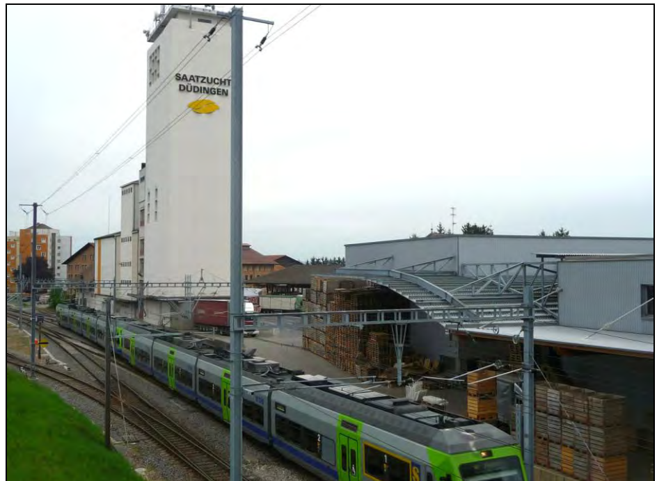
Abbildung 76: Die Saatwucht Düdingen verwertet die Getreideabfälle energetisch und zur Trocknung des Getreides und Getreidepelletproduktion. Photo: M. Gutschner
