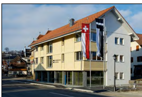
Verwaltungsgebäude (EBF 557 m 2 ) in Plaffeien
