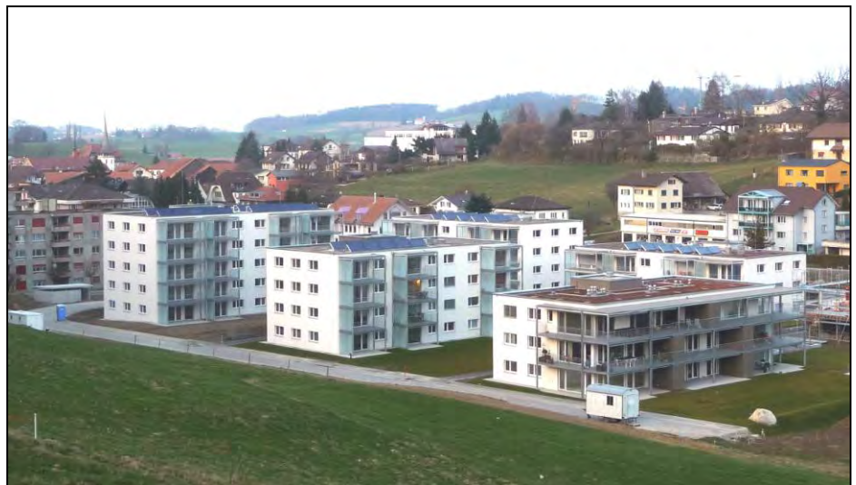
Abbildung 64: Die neue Überbauung (Baujahr 2010 und 2011) auf der Maggenbergmatte in Tafers setzt auf Solarwärme. Photo: M. Gutschner
