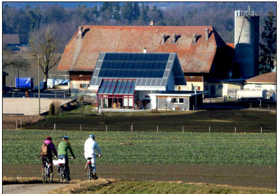
Abbildung 63: Der kleine Weiler Uttewil (Gemeinde Bösinggen) hat schon einige grosse Energieleistungen vollbracht. Im Bild das Sonnenhaus (100% solar beheizt) und Hof mit Biogasanlage (Anlage hinter dem Gebäude). Photo: M. Gutschner
