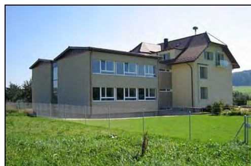
Schulgebäude (EBF 856 m 2 ) in St. Ursen
