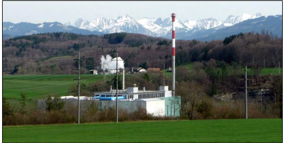
Abbildung 79: Die Kehrichtverbrennungsanlage in Posieux verwertet einen grossen Teil der Siedlungsabfälle der Region Sense und produziert daraus Strom und Wärme. Photo: M. Gutschner
