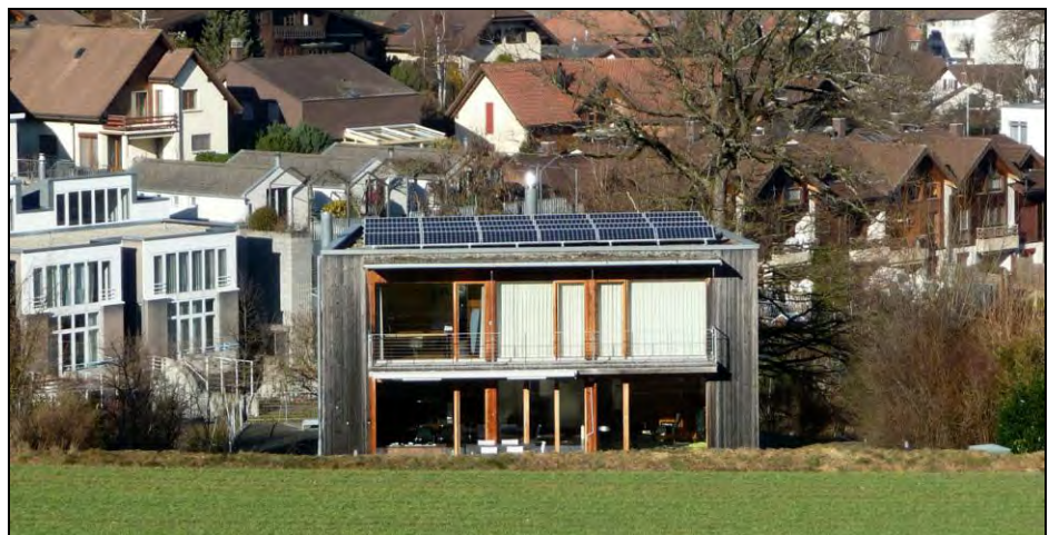
Abbildung 67: Einfamilienhaus mit aktiver und passiver Solarenergienutzung in Schmitten. Photo: M. Gutschner
