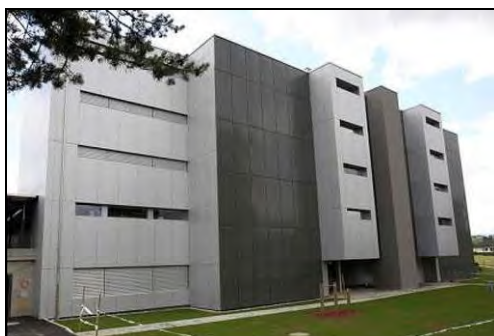
Schulgebäude (EBF 6'575 m 2 ) in Düringen
