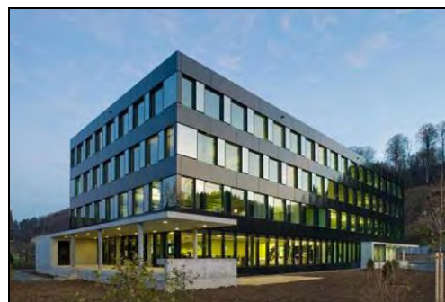
Verwaltungsgebäude (EBF 3'534 m 2 ) in Flamatt
