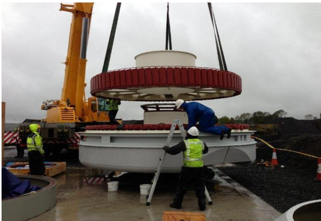
Figur 15, Montering av generator og hovedlager på en EWT turbin.
