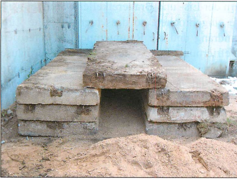
Abb. 16. Versteckter Eingang mit Kriechgang aus Betonplatten.
