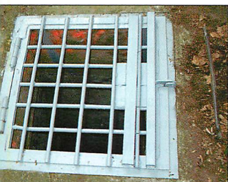
Abb. 18. Bunker Lossow: Unter der Stahlplatte der Gitterklappe befindet sich das Schloss.
