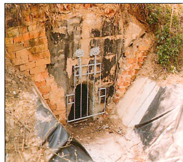
Abb. 27. Maßnahme zur Verbesserung der Bewetterung.
