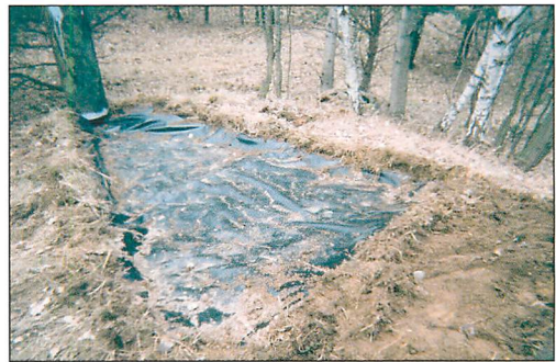
Abb. 51. Raketenbunker Königsbrücker Heide: Folie zur Sammlung von Regenwasser und Einleitung ins Quartier - Luftfeuchteoptimierung.
