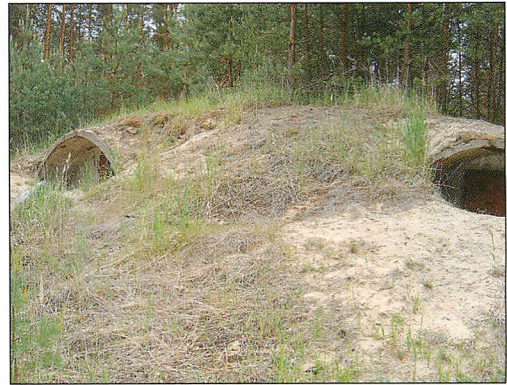
Abb. 12. Ehemaliger Schießplatz Tauer (Sachsen). Bunkertüren dauerhaft verschlossen und anschließend verfüllt.
