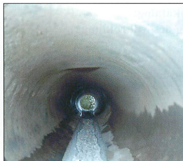
Abb. 26. Maßnahme zur Verbesserung der Bewetterung.
