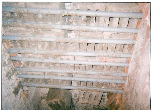
Abb. 2. Anbringen von Großkammersteinen auf Stahlrohren, die auf dem Bunkerwand-Sims liegen.
