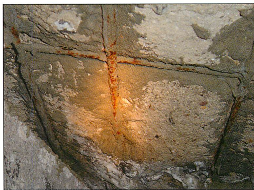
Abb. 47. Bunkerkomplex Saßnitz-Dwasieden: Stahlsanierung – ebenfalls eine Sicherungsmaßnahme.
