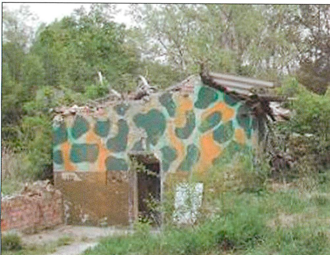
Abb. 36. Dönitzbunker: Ehemaliger Haupt-Eingangsbereich zum Objekt.
