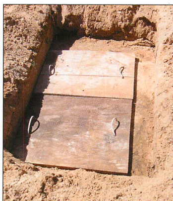
Abb. 14. Abdeckklappe auf diesem Bunkereingang.
