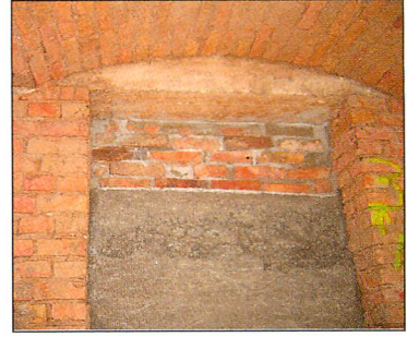
Abb. 30. Beispiel für das Vermauern von Türen.
