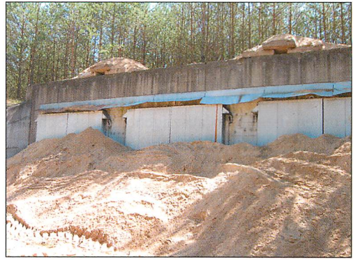
Abb. 17. Überdeckung des Kriechganges mit Sand.
