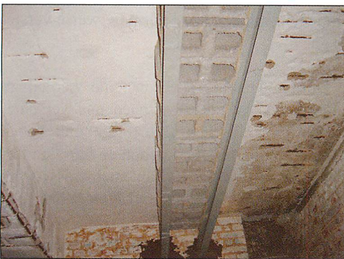
Abb. 1. Großkammersteine auf Doppel-T-Trägern.
