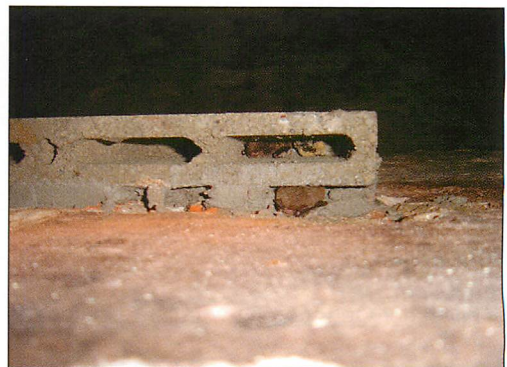
Abb. 45. Brauereikeller Anklam: Strukturverbesserung durch Hohlblocksteine, die schon im ersten Winter akzeptiert wurden..
