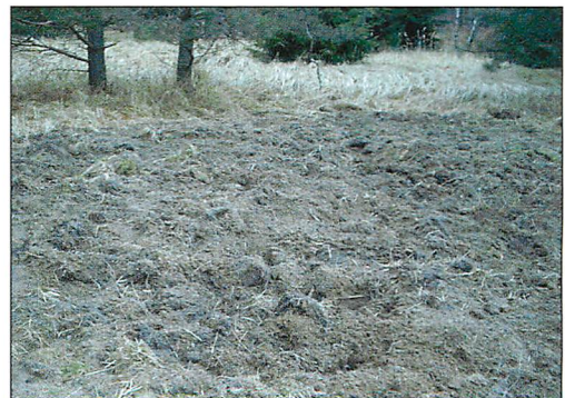
Abb. 24. Bunker Spechthausen-Mechlow: Erdbedeckung nach Einbau der Bewässerung.
