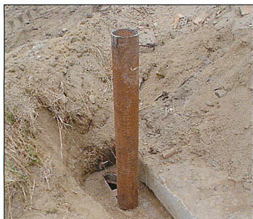
Abb. 25. Maßnahme zur Verbesserung der Bewetterung.
