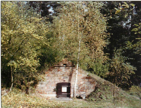
Abb. 30. Quartier Nr. 15. Anfang Oktober 1996, das fast fertige Winterquartier.
