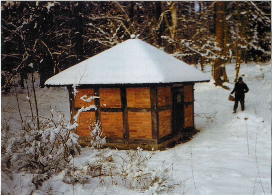
Abb. 37. Ansicht des Winterquartiers Junkernhof Brunnenhaus.
