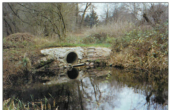
Abb. 3. Blick auf den Stollenmund von Quartier Nr. 5: Sommerbeck Stollen, Ein- und Ausflug der Fledermäuse. Alle Aufn.: G. u. W. SCHULZ.
