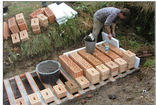
Abb. 17. Quartier Nr. 11. Aufbau der Decke aus Porotonbetten und Beginn der Einkleidung mit Porenbetonplatten.
