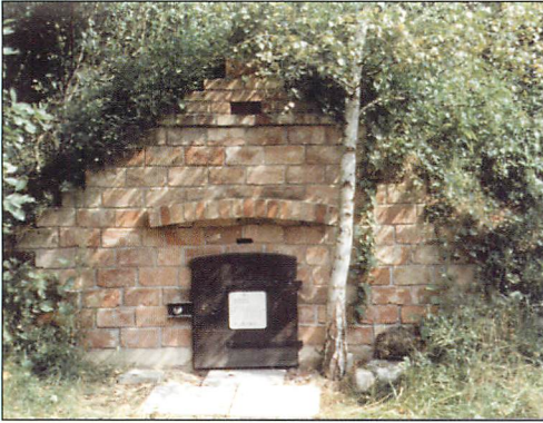
Abb. 32. Quartier Nr. 15. Sept. 1997: Frontansicht des fertigen Quartiers. Zwischen Tür und Bogen ist der Einkriechschlitz für die Fledermäuse erkennbar. Rechts neben der Birke befindet sich die durch Steine verdeckte Öffnung für die Molche.
