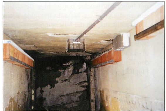
Abb. 38. Rechts und links sind Reihen von Poroton-Versuchsbetten an den Wänden installiert. In der Mitte der Decke ist die Wasserzuleitung von der Regenfanganlage und ein Sammelbehälter zu sehen, von dem die rechte Bettenreihe durch einen Schlauch regulierbar bewässert wird.
