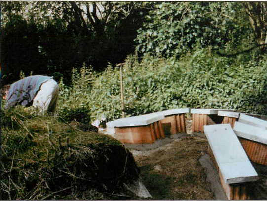
Abb. 5. In die Betondecke von Quartier Nr. 5 wurden Öffnungen geschnitten, auf die die Porotonbetten gemauert wurden.
