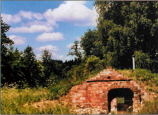
Abb. 43. Winterquartier Junkernhof Bohrkeller.
