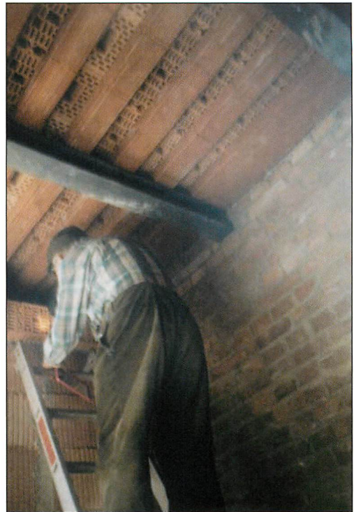
Abb. 11. Der Blick auf die Ausbaudecke von Quartier Nr. 10 zeigt die Ziegelstürze, die als Auflage für die Porotonbetten verwendet wurden.
