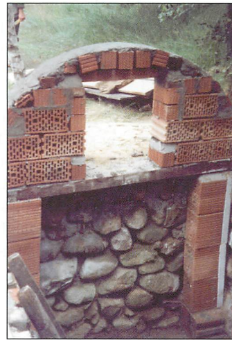
Abb. 25. Quartier Nr. 15. Vorderer Gewölbekeller mit Kontrolltüröffnung.
