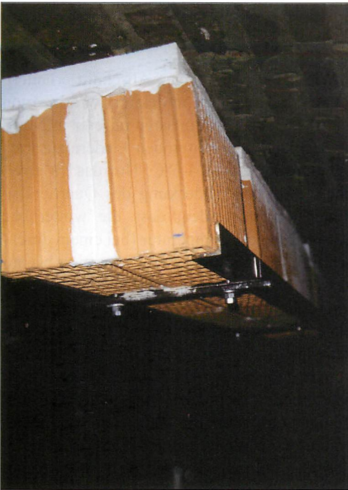
Abb. 35. Doppelreihe von Porotonbetten im Zenit eines Gewölbes befestigt (seitliche Ansicht).
