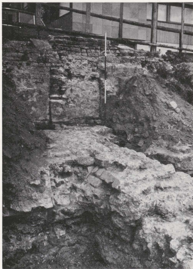
ABB. 6. Schrägsockel an der westlichen Verbindung zwischen Tor und Mauerzug. In der Vermauerung im Hintergrund sind noch aufgehende Teile der westlichen Torwange erhalten. Ansicht von Südwesten.
