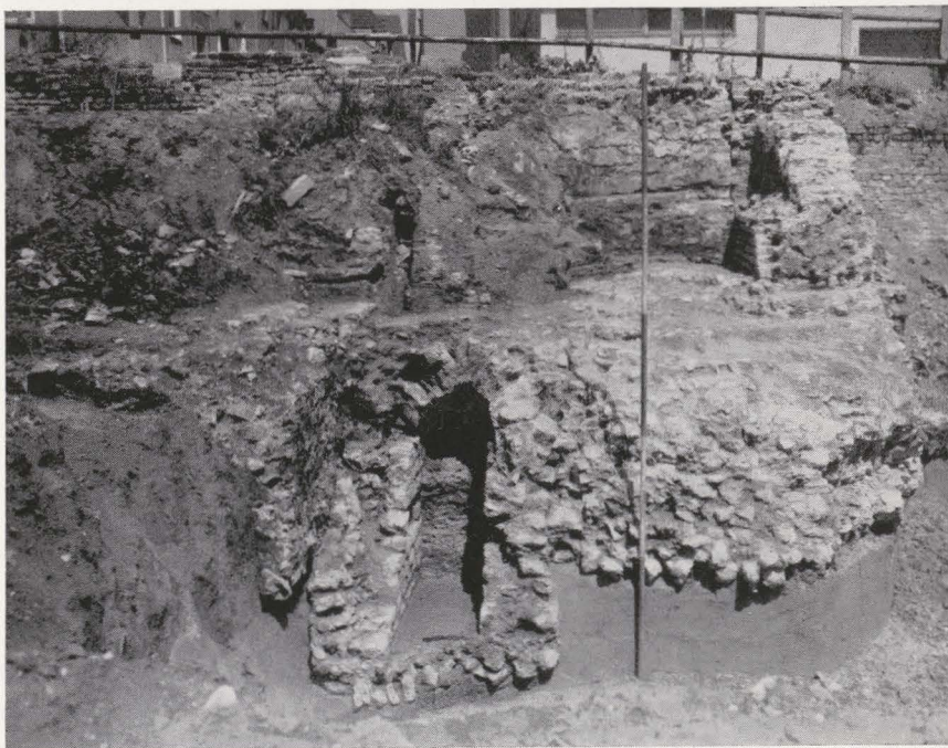
ABB. 4. Reste des neunten Stadtttores von Köln mit dem Abwasserkanal in der Fundamentplatte und der östlichen Torwange (rechts oben). Ansicht von Süden.
