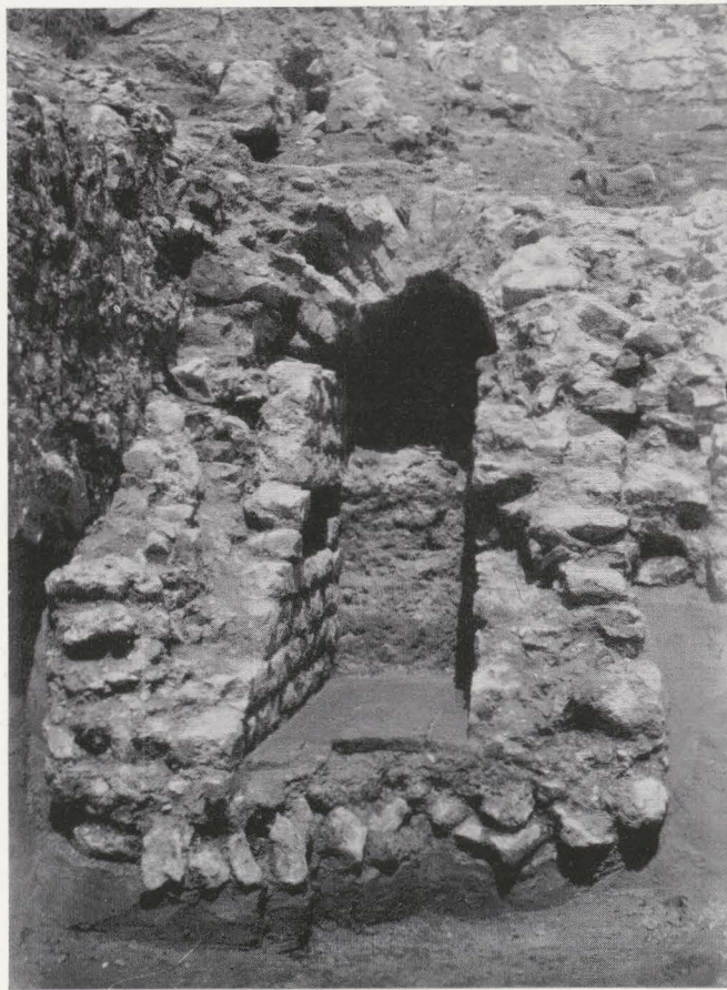
ABB. 7. Der Abwasserkanal unter des Torfahrt des neunten Stadttores des römischen Köln. Ansicht von Süden.
