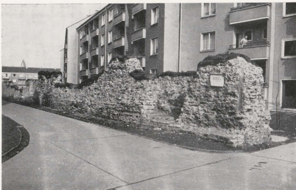
ABB. 1. Blick von Westen auf die Aussenfront der römischen Stadtmauer von Köln am Mauritiussteinweg (Interturrium 32).
