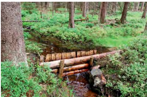
Abb. 4. Abdichten von Entwässerungsgräben im Heinersbach-Quellmoor. – Blocking of drainage ditches in the Heinersbach Quellmoor (a valley-mire).
