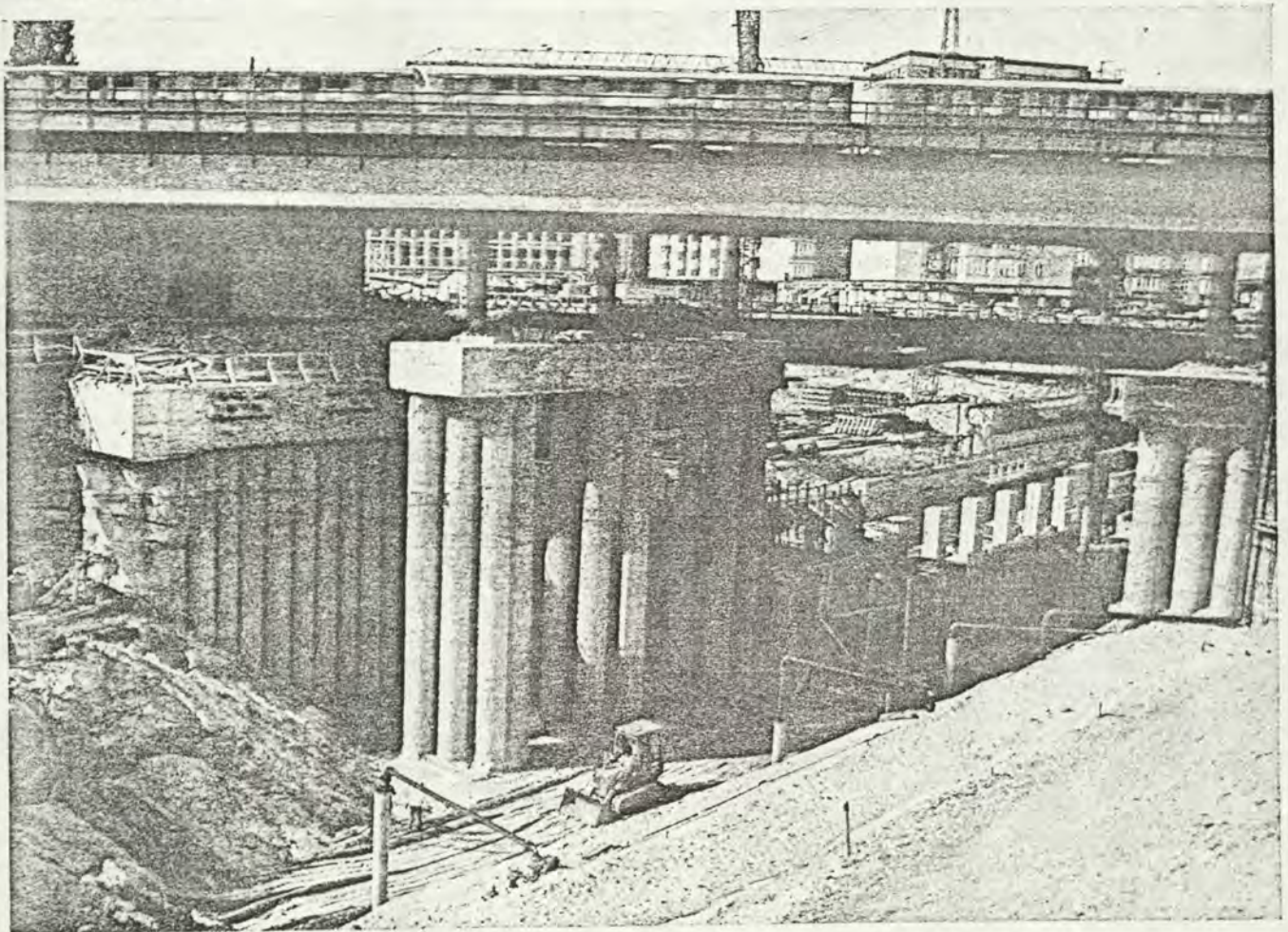
Bild 12: Blick von Südosten auf die freigelegten Stützenreihen 6 und 7 und das Widerlage B der Eisenbahnbrücke. Bauzustand für die Herstellung der U-Bahn. Fotos: Schwiering
