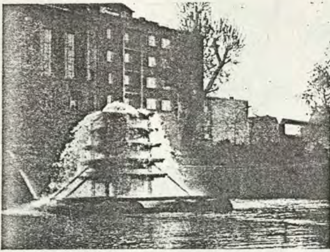
Bild 7: Einleitung des Grundwassers am Wilmersdorfer Fennsee über eine Kaskade Foto: Schwiering
