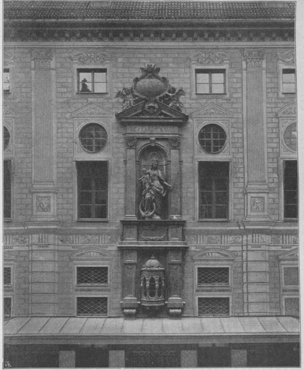
Mittelteil der Fassade.
