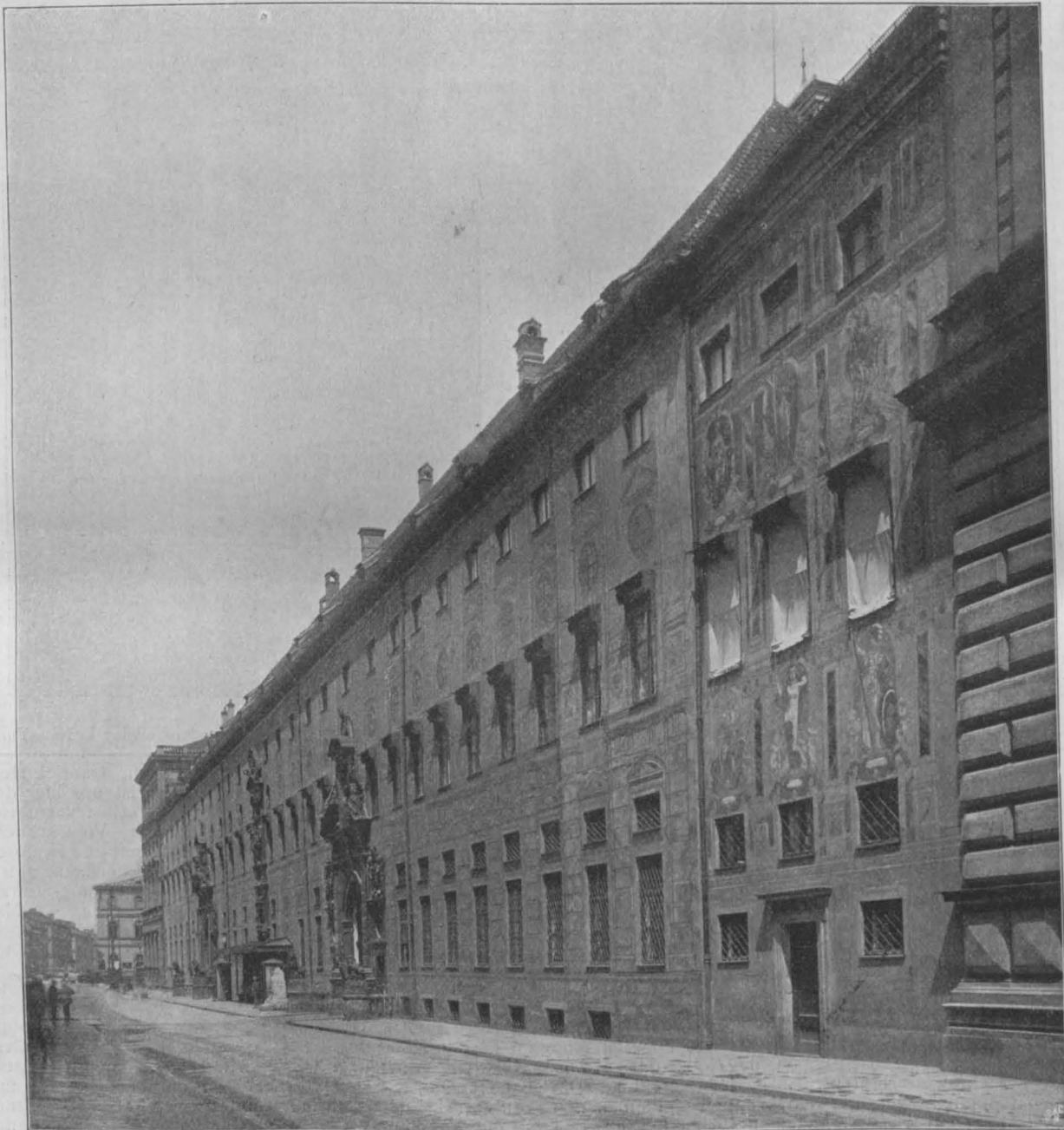
Die Wiederherstellung der Fassade der alten Residenz in München. Hauptfassade von Süd nach Nord.
