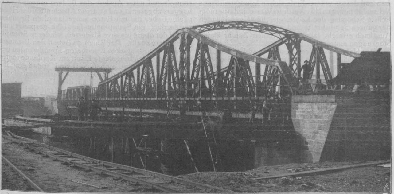
Abbildung 9. Doppelgleisige Eisenbahn-Drehbrücke im neuen Ruhrorter Hafen über den Durchstich zwischen Kaiserhafen und Hafencanal.
