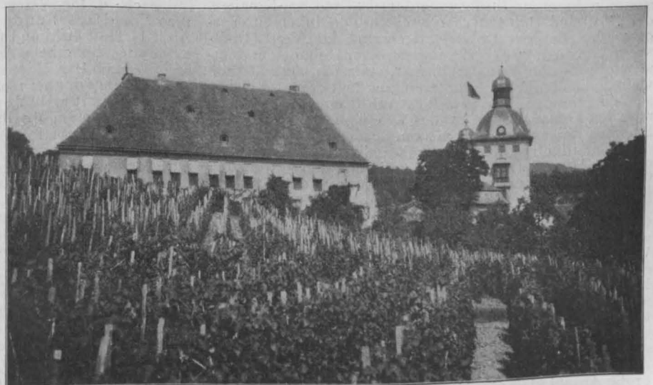
Zustand des Schlosses vor dem Umbau.
