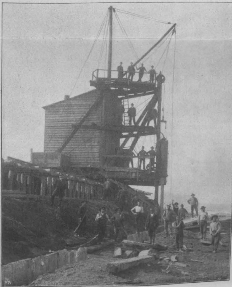
Abbildungen 7 und 8. Rahmen für die Herstellung des Bohlwerkes in Eisenbeton (Ausführung Möbus) mit Aufzugskran.
