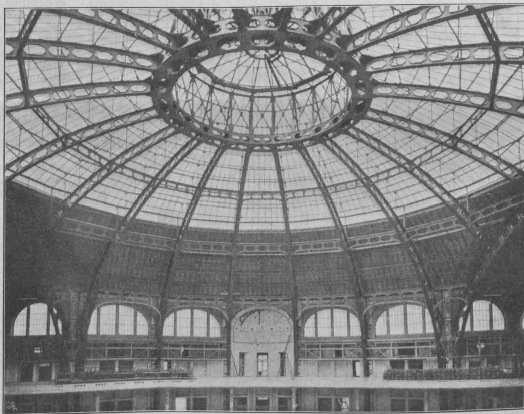
Aufstellung der Hallenkonstruktion, Stand am 25. März 1908, und Blick in die fertige Kuppelkonstruktion. Die Ausstellungs- und Festhalle zu Frankfurt am Main.
