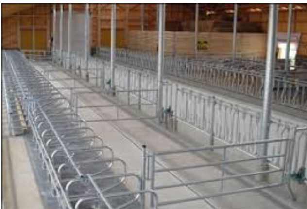
Abbildung 20: Ausführung Abtrenngitter zwischen den Jungrindern; Quelle: Kristen Stalleinrichtungen
