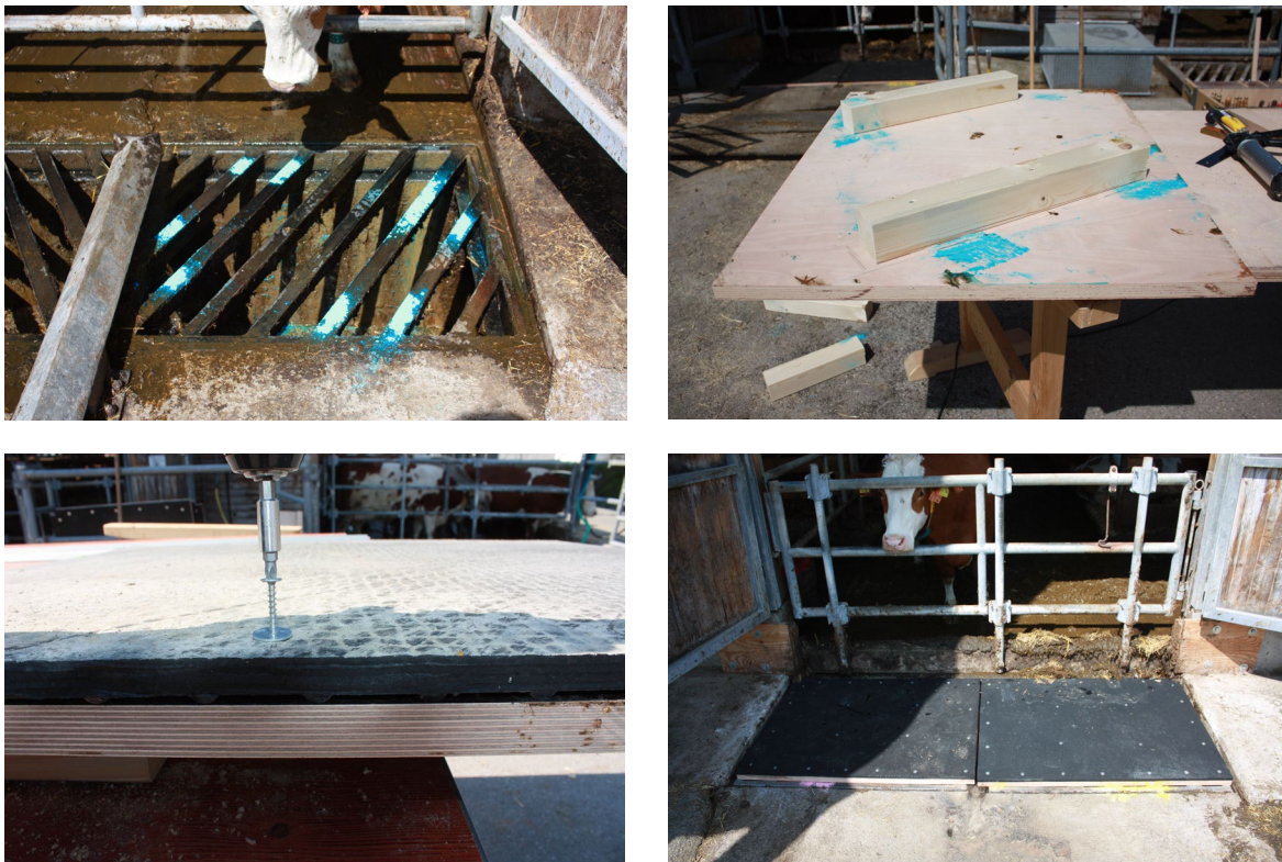
Abbildung 38: Abwurfschacht mit Abdeckung in Achselschwang
