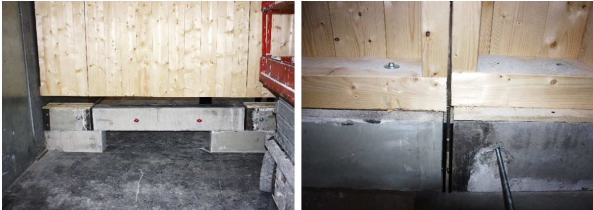
Abbildung 53: Betonschwelle mit dem Holzaufbau Foto: TH Rosenheim
