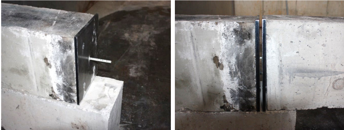
Abbildung 51: Montage der Betonschwelle
