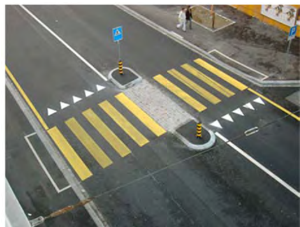
Abbildung 32 Wartelinie vor Fussgängerstreifen – Wirkung belegt
