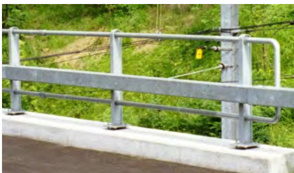
Abbildung 51 Rohrbogen als Geländerabschluss
