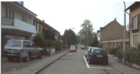
Abbildung 45 Versetzte Parkfelder in einer Tempo-30-Zone
