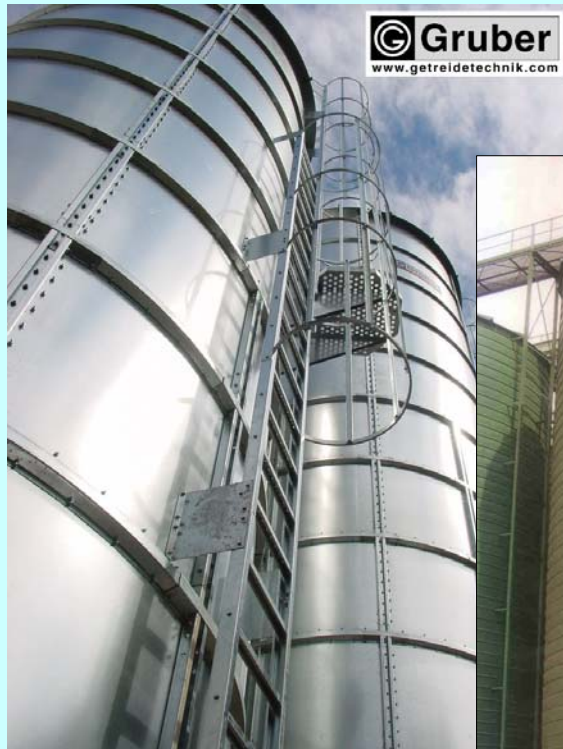
Glattwandsilos mit außen liegendem Steifenraster (System Gruber)
