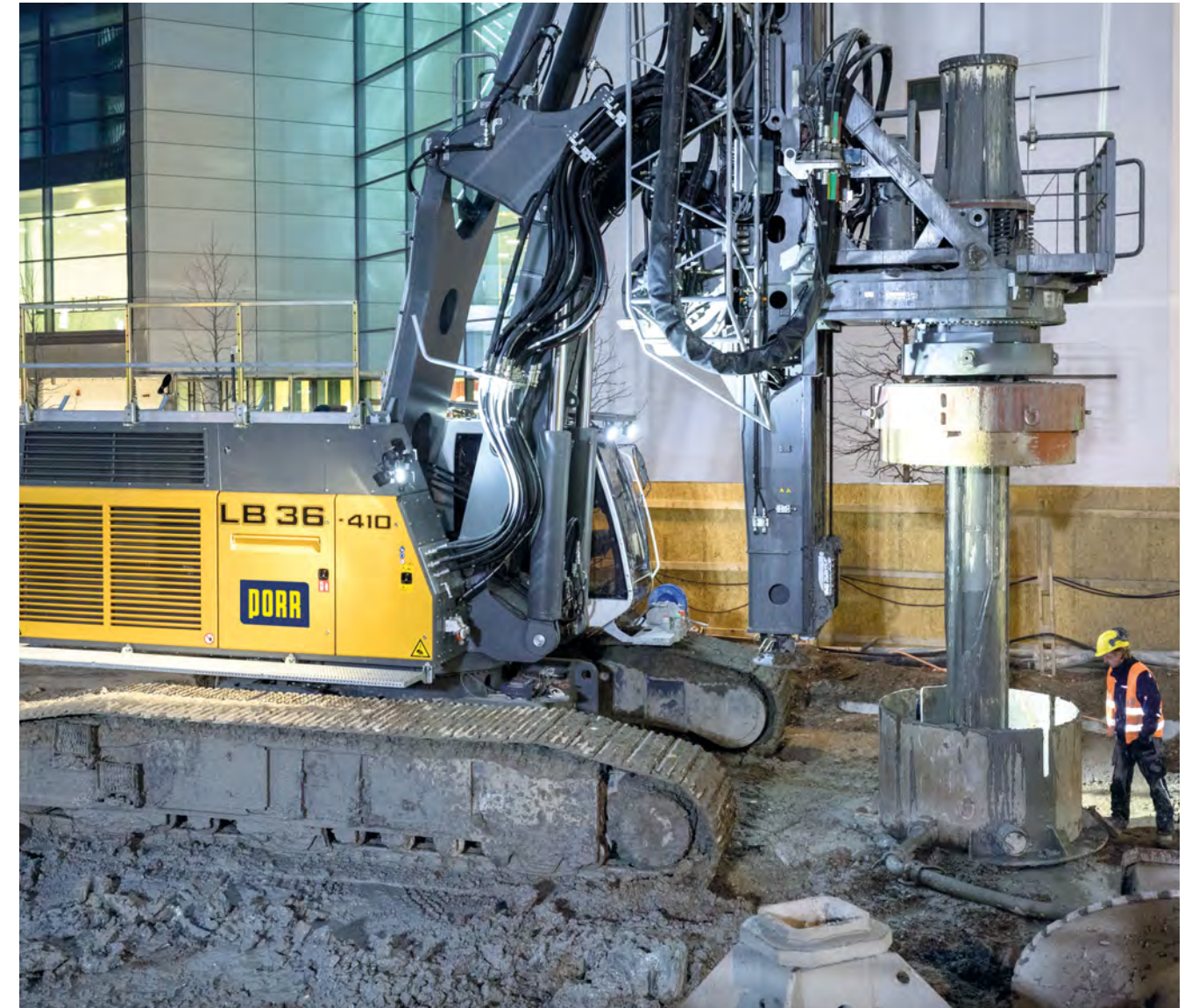
Das Bohrloch wird durch die Zufuhr von Bentonitsuspension gestützt
