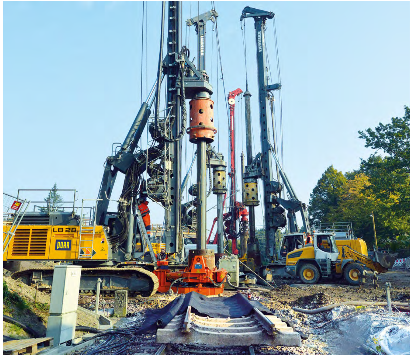
Einsatz von vier Drehbohrgeräten während einer Sperrpause im Gleisbereich
