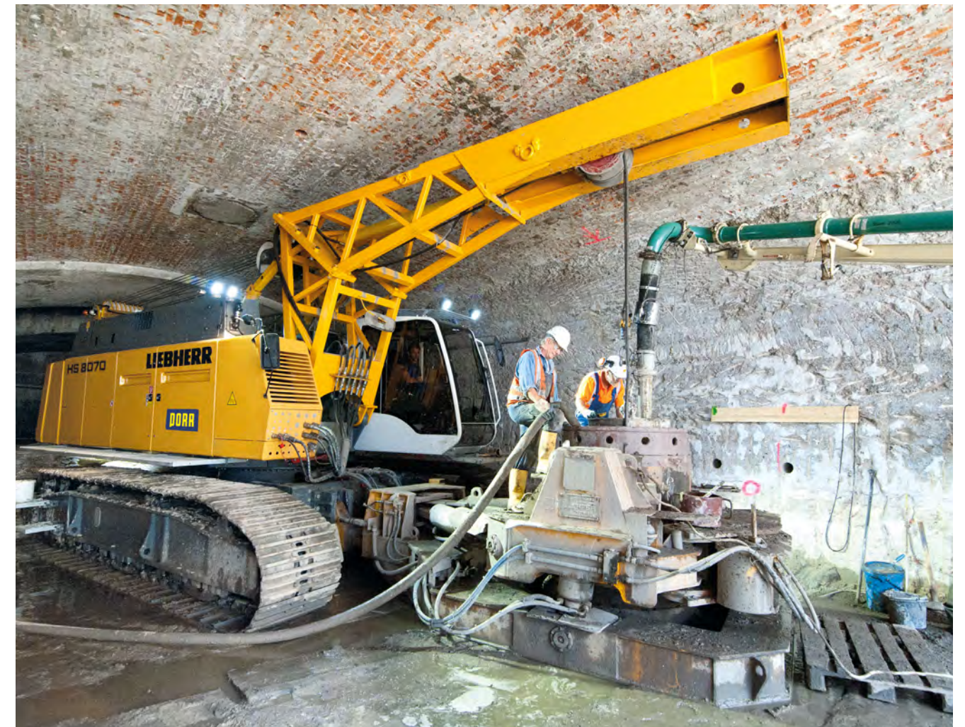
Hamburg Kasematten: Herstellung unter beschränkter Höhe im Greiferverfahren
