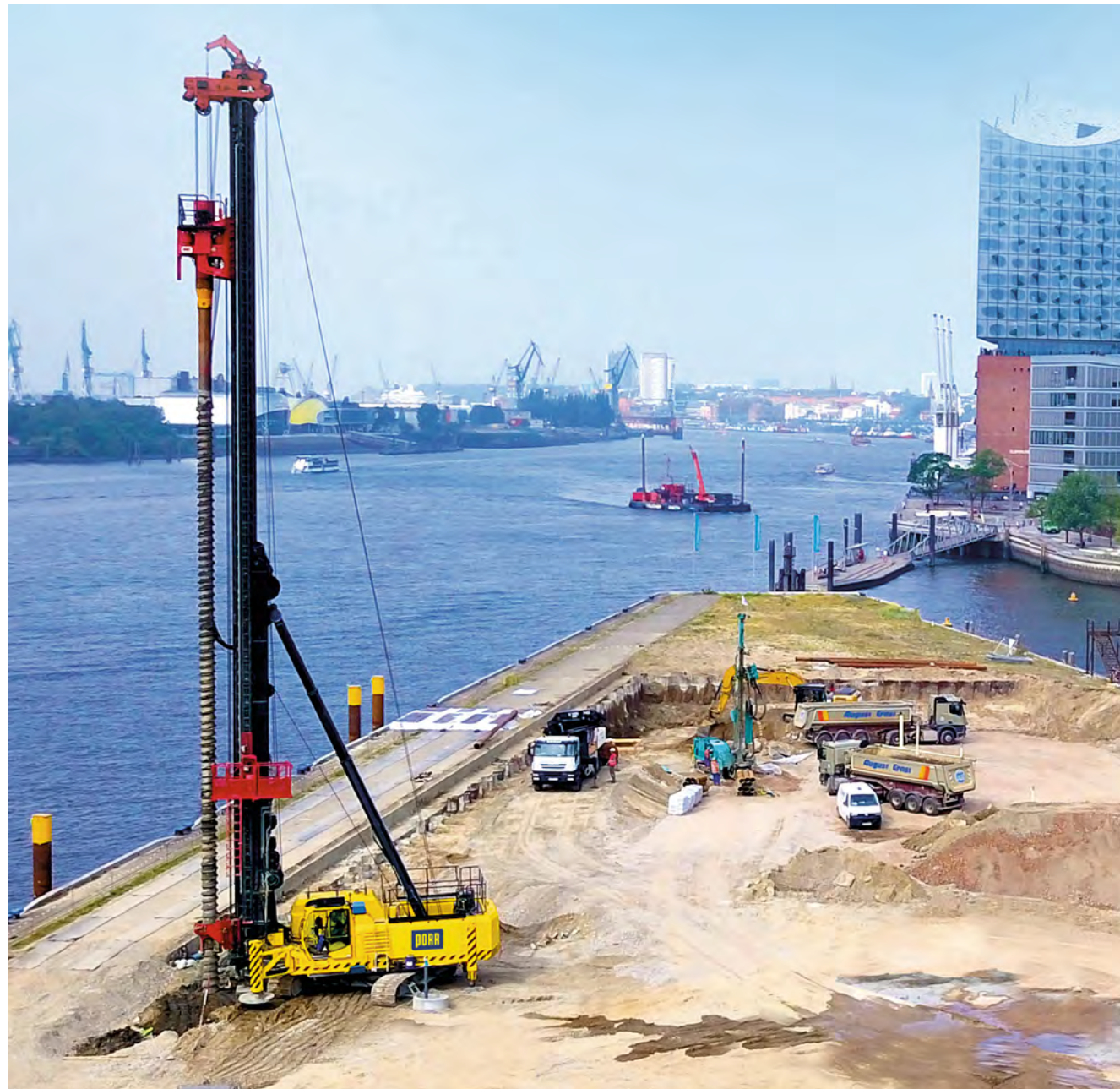
Teilverdrängungsbohrpfähle für Quartier Strandkai in Hamburg.
