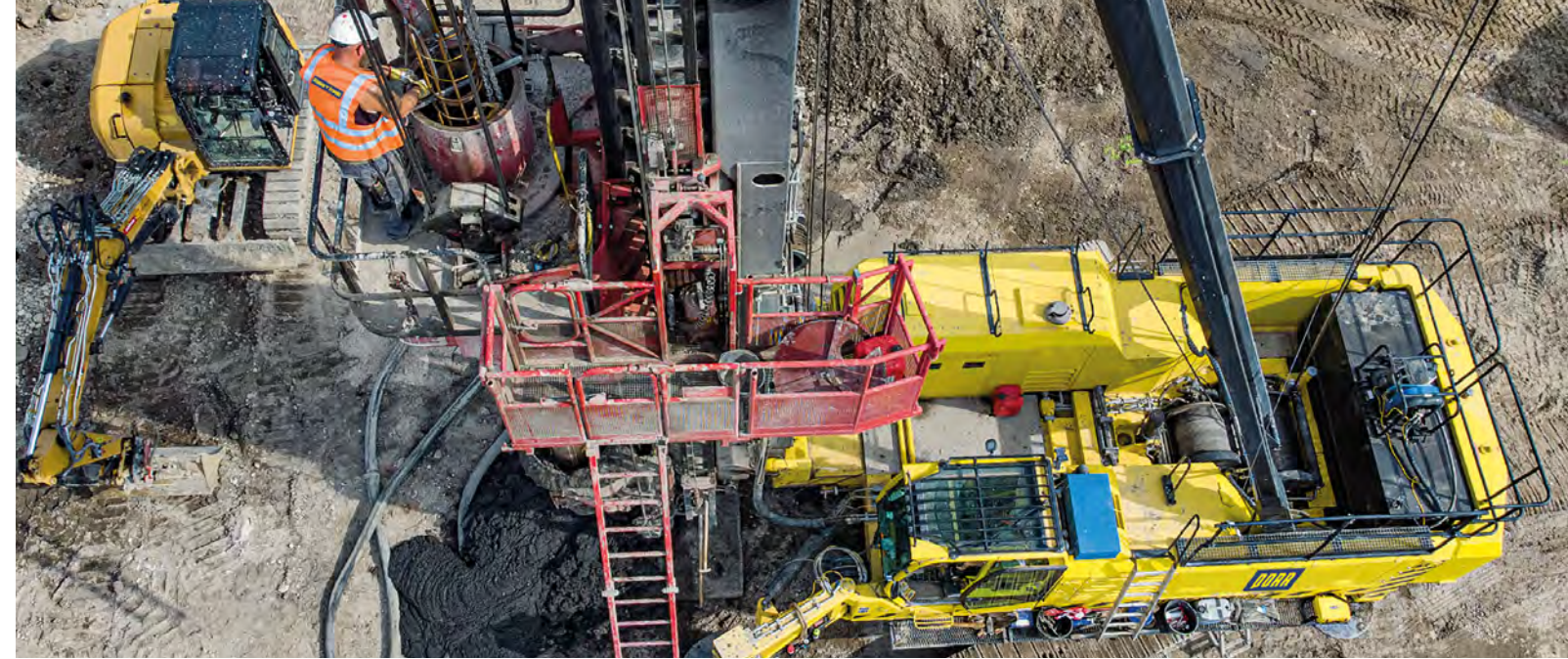
Betonieren eines Teilverdrängungsbohrpfahles
