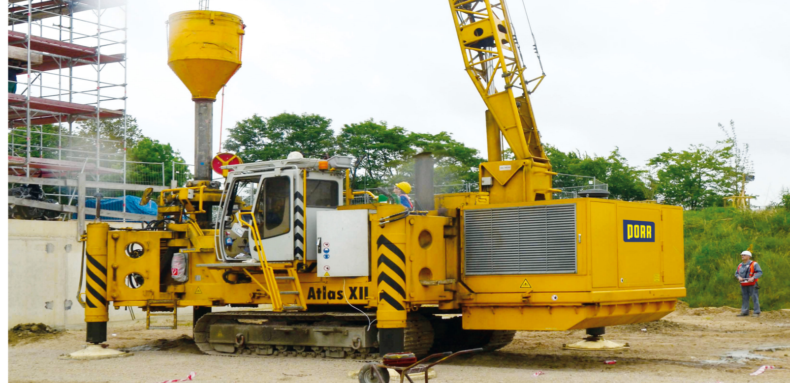
Einstellen eines Bewehrungskorbes beim Atlaspfahl
