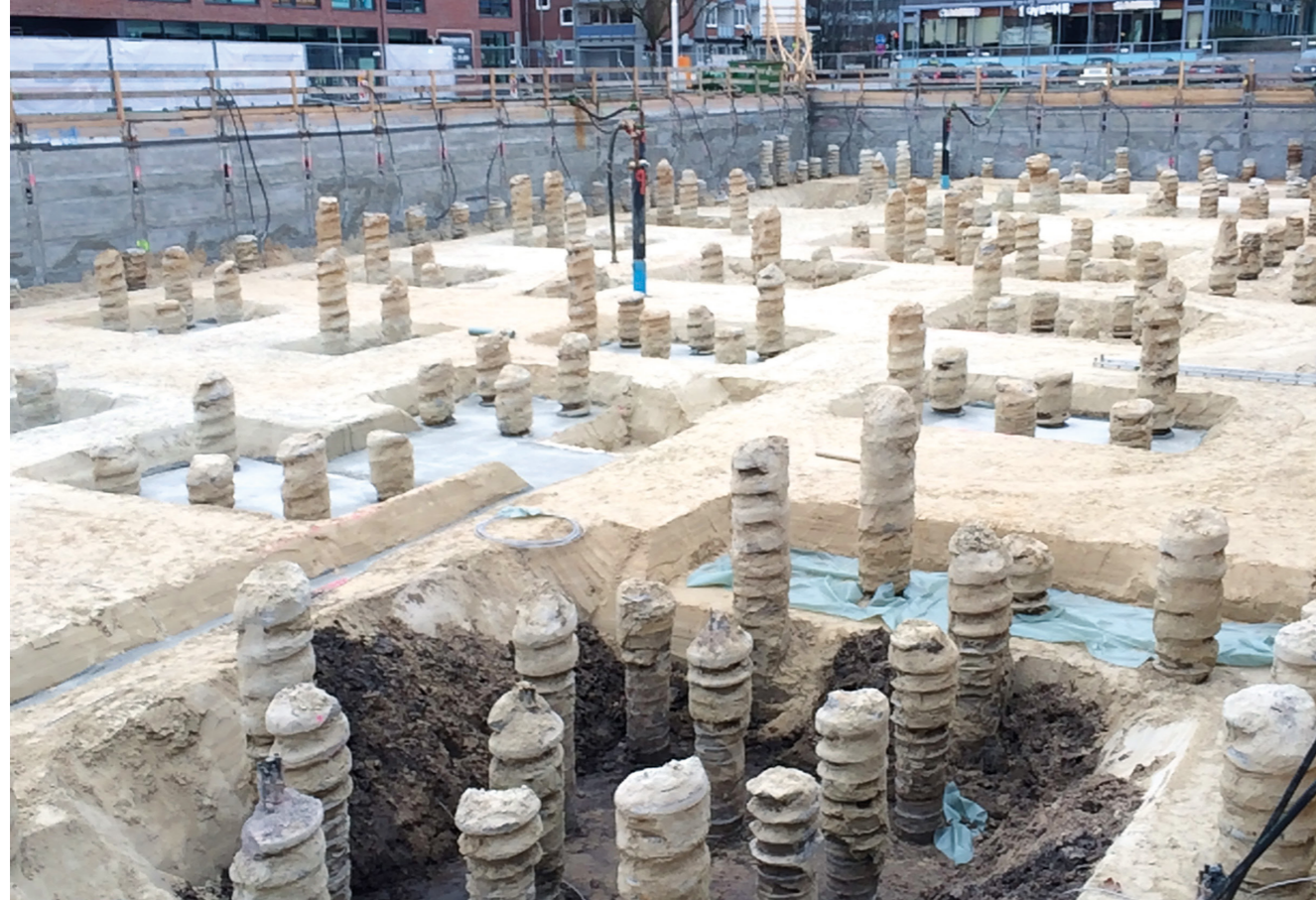
Freigelegte Atlaspfähle vor dem Kapfen
