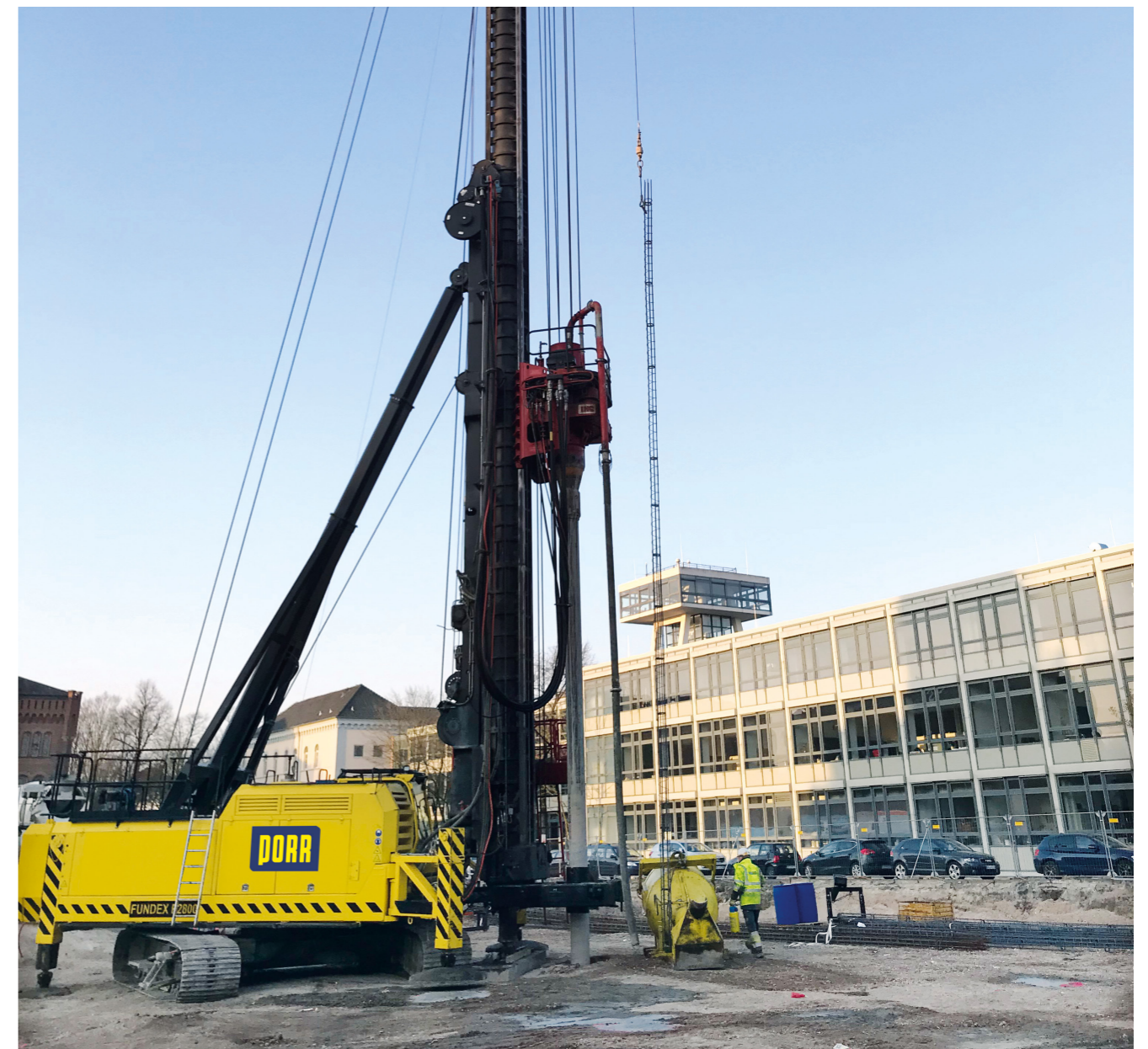
Herstellung von Atlaspfählen in Oldenburg
