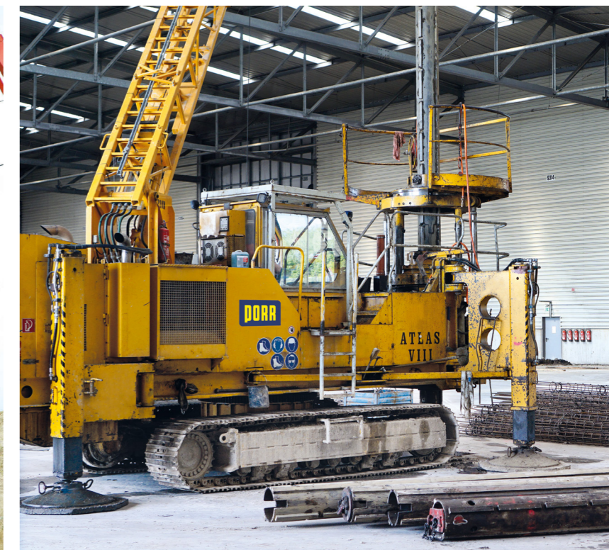
Aufgrund der eingeschränkten Arbeitshöhe werden die Bohrröhre in mehreren Schüssen eingebracht und die Bewehrungskörbe mehrmals gestoßen.
