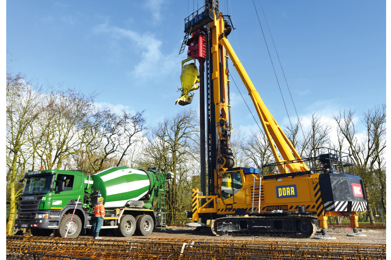
Herstellung von Fundexpfählen in Wangerland
