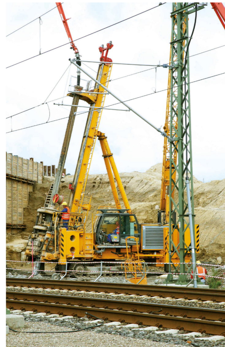
Erschütterungsfreie Ausführung mit Atlaspfählen neben Bahngleisen.
