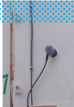
Soliphant T FTM20 zur Grenzüberwachung im Trockenmörtelsilo
