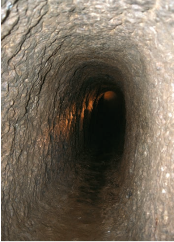
▲ Abb. 198 Blick in einen mit Schlägel- und Eisenarbeit vom Tal- bach her aufgefahrenen Stollen im Besucherberg- werk Erich (Niveau St. Josephi-Stollen).
