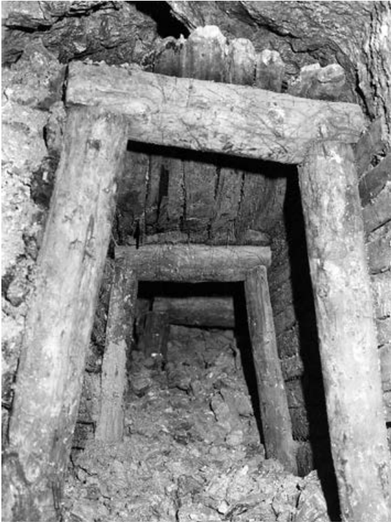
▲ Abb. 191 Türstöcke aus der ersten Hälfte des 18. Jahrhunderts.
