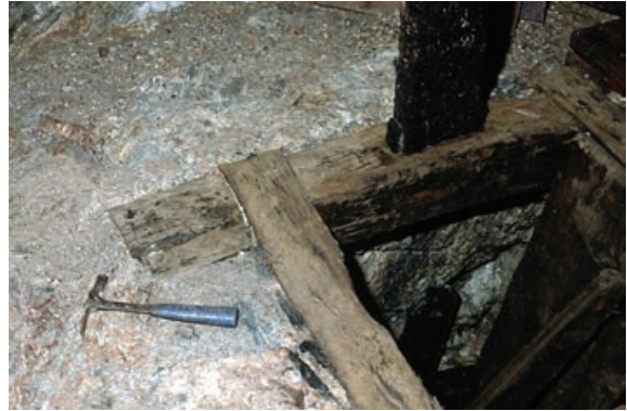
▲ Abb. 189 Schachtrahmen am Haspelgesenk von 1530, mit großer Genauigkeit in den Gneis eingelassen.
