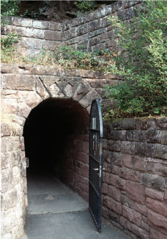
▲ Abb. 134 Aus Sandstein gemauertes Portal des Besucherbergwerks Hella-Glück-Stollen (Foto 2003).
