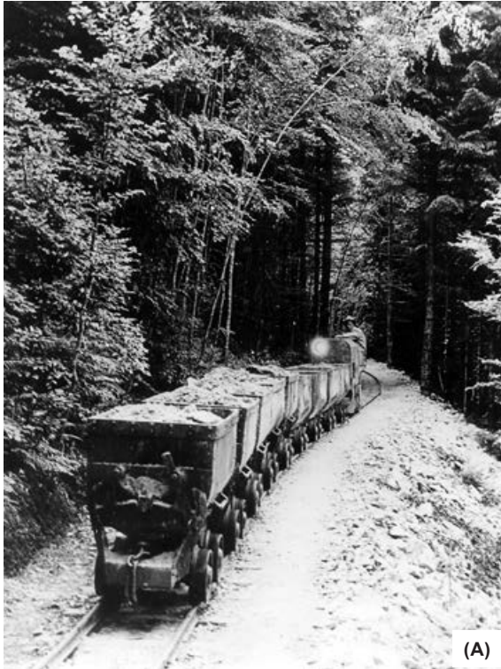
Abb. 231 Flussspatbergbau bei Wieden (Aufnahmen ca. 1965).
