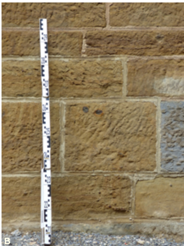
Abb. 2.1-18: (A) Burg Hohenzollern bei Hechingen. Der größte Teil der umfangreichen Anlage ist aus Angulatensandstein erbaut, der in zahlreichen kleinen Steinbrüchen im nördlichen Vorland der Burg gewonnen wurde. (B) Typische Mauerquader von Angulatensandstein auf der Burg.
