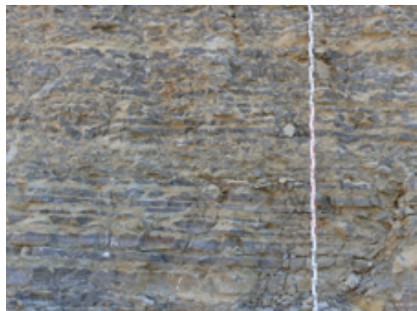
Abb. 2.1-7: Dünnschichtiger Plattenkalk mit beigefarbenen dolomitischen Mergelsteinlagen, Steinbruch Brigachtal-Klengen (RG 7916-2, Länge des Maßstabs: 3 m).
