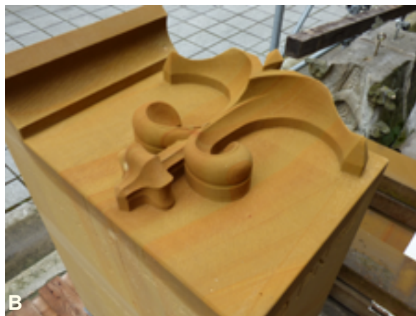
Abb. 2.1-15: (A) Zum Abtransport zur Ulmer Münsterbauhütte gerichtete Tranchen aus Eisensandstein im Natursteinwerk Bamberg (B) Erste Bildhauerarbeiten aus Eisensandstein für das Ulmer Münster auf dem Hof der Münsterbauhütte.
