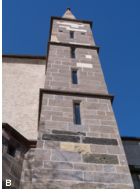
◀ Abb. 2.1-13: (A) Gewinnung von Kaiserstühler Tuffstein am Achkarrener Schlossberg im März 2004. Die Lösung erfolgte mit der Schwertsäge, der Transport aus dem Abbau mit einem Baggerfahrzeug. (B) Vollständig mit vulkanischem Tuffstein renovierter Treppenturm am Breisacher Münster St. Stephan.
