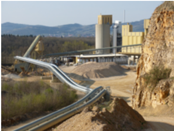
Abb. 1.3-3: Gruben- und Werksproduktion: Über ein eingehautes Förderband wird im Steinbruch Merdingen (RG 7912-2) die verwertbare Förderung (= Grubenproduktion) zum Werk transportiert, um dort zu verschiedenen Verkaufsprodukten (häufig unter Verwendung anderer mineralischer Rohstoffe) verarbeitet zu werden.
