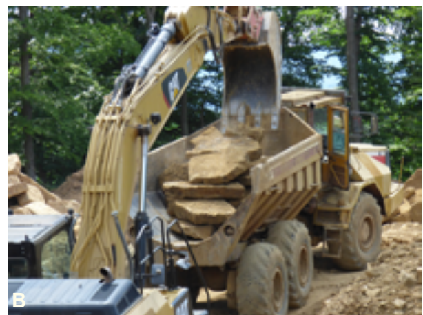
Abb. 2.1-19: (A) Gewinnung von Angulatensandstein bei Grosselfingen im Juni 2018. Der Probeabbau zeigte schon kurz nach Beginn, dass die Gesteinsqualität und die Quader- bzw. Plattenformate den Erfordernissen des Sanierungsprojektes entsprechen. (B) Die mit dem Bagger abgehobenen Quader und Platten werden nach Größen sortiert; danach soll die probeweise Bearbeitung durch den Steinmetz erfolgen.
