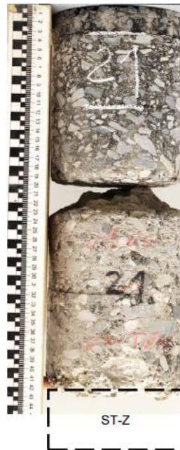
Abbildung 42: Sichtbare Beschädigung der zementstabilisierten Tragschicht im Zuge der Bohrkernentnahme (Baustelle A9)
