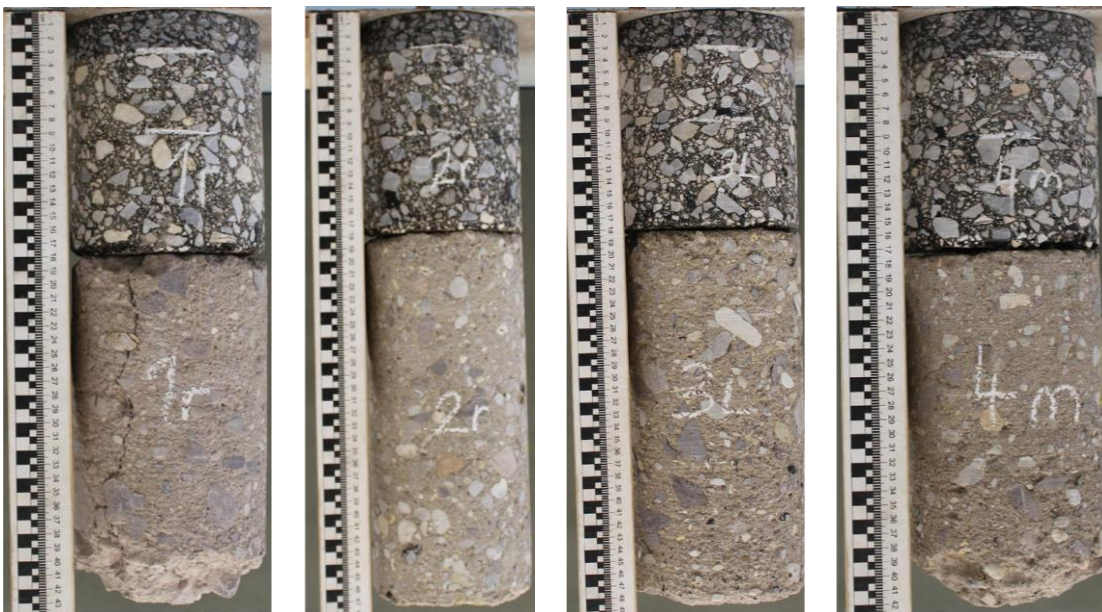
Abbildung 41: Vier Bohrkern der Baustelle A5 zur Bestimmung des vorhandenen Schichtverbunds zwischen Asphaltenschicht und zementstabilisierter Tragschicht
