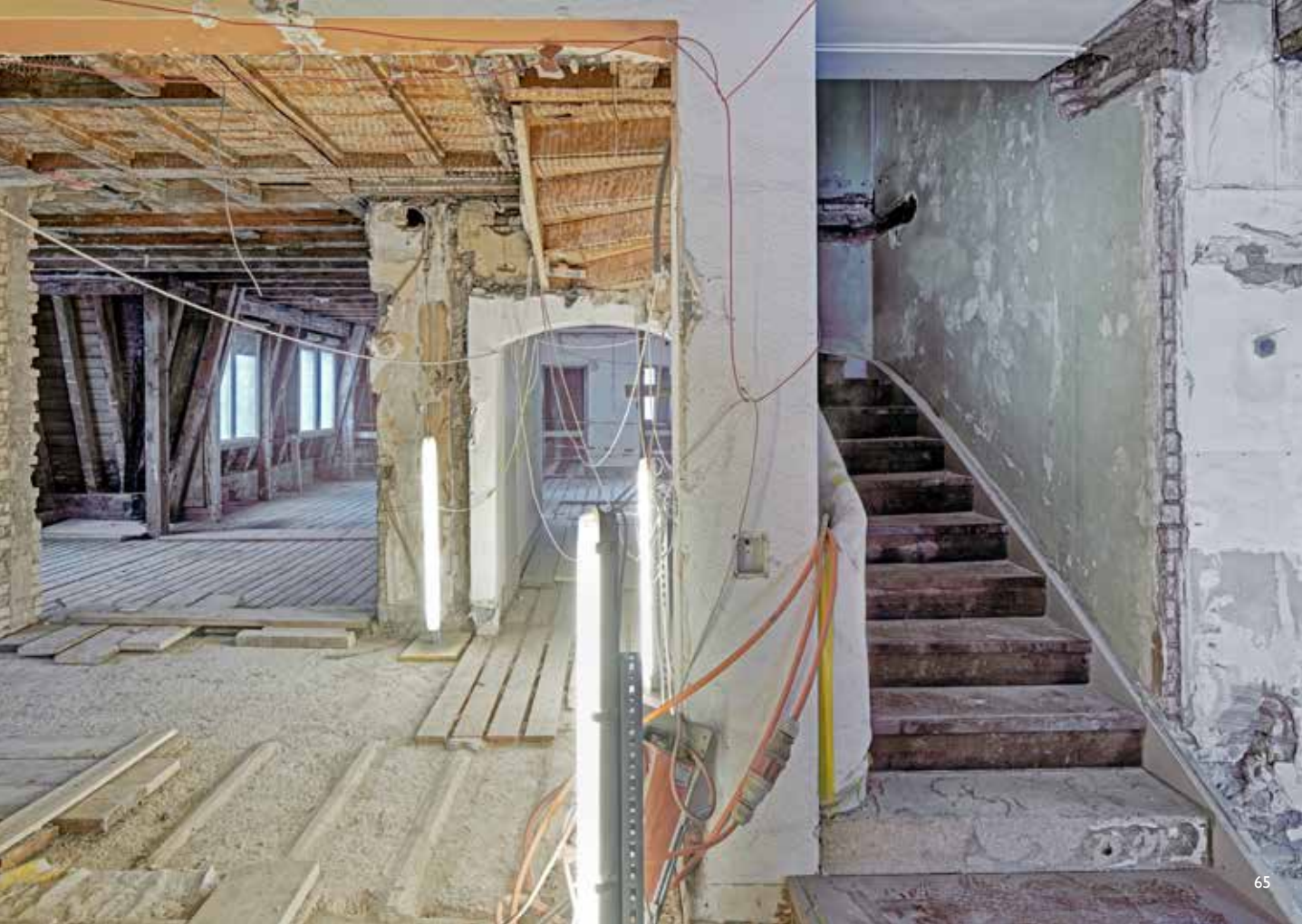
I. Dachgeschoss 2018, Büros (ehem. interne Treppe)
