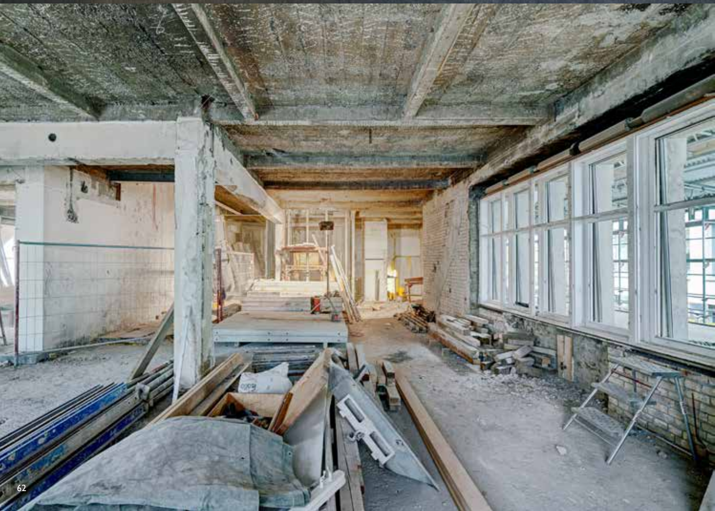
Parterre 2018, Büros (ehem. Lagerraum)
