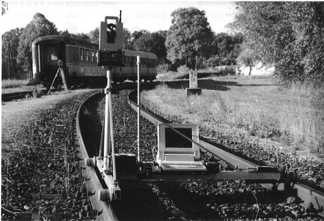
Abb. 5.2: Gleisaufnahme mit einem Meßrobotersystem
