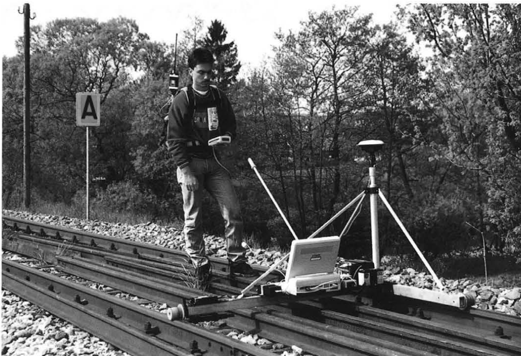
Abb. 5.3: Gleisaufnahme mit einem GPS-Echtzeitvermessungssystem
