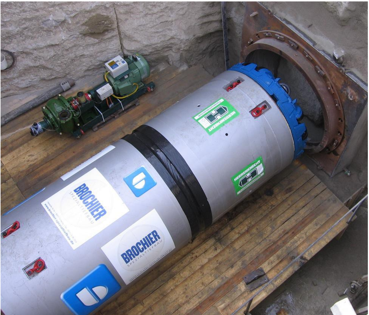
Abbildung 4.2: AVND 1600 im Startschacht Projekt ASKE
