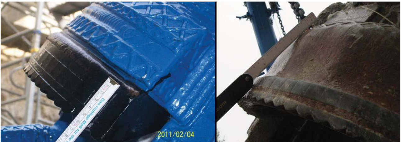
Abbildung 4.7: Verschleißbild der Räumler [24]
