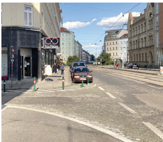
Abb. 52 (oben): Durchgezogener Gehsteig entlang der Klybeckstrasse: Fußgänger*innen haben Vorrang und können einmündende Straßen ohne Niveauunterschiede queren. Wichtig: Damit sich Personen mit eingeschränkter Sehfähigkeit trotz fehlendem Randstein orientieren können sind Blindenleitlinien angebracht.
