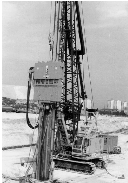
Abb. 5.7: Seilbagger im Einsatz [6] entnommen [24, Abb. 12.14]
