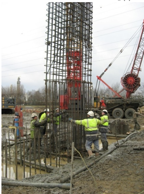
Abb. 3.8: Einbau der Bewehrung [2]
