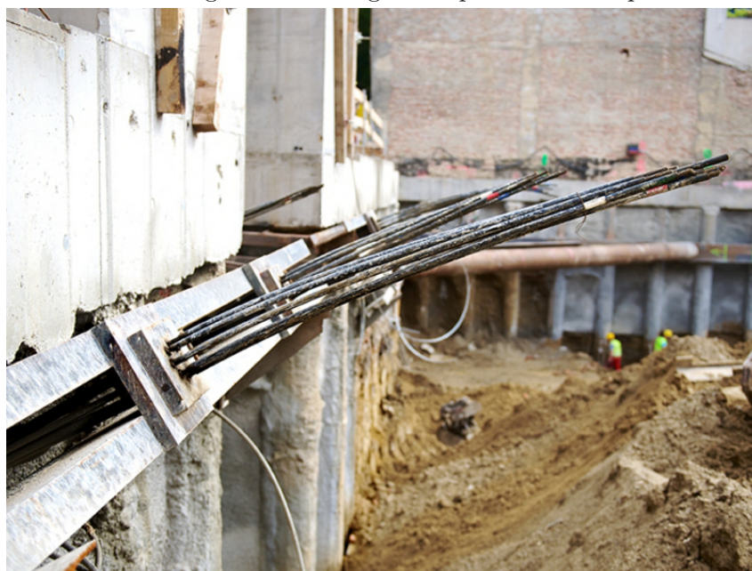
Abb. 6.2: Rückwärtige Verankerung im Kopfbereich bei Spundwänden [8]
