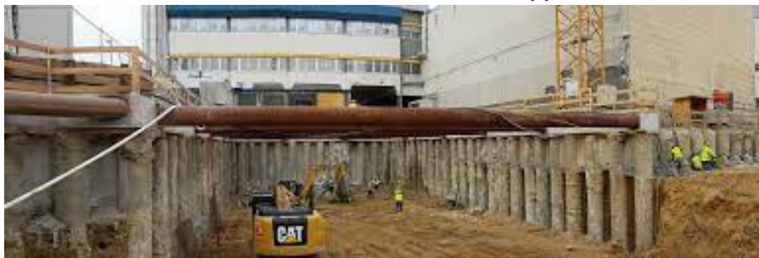
Abb. 6.1: Ausgesteifte Baugrube [7]
