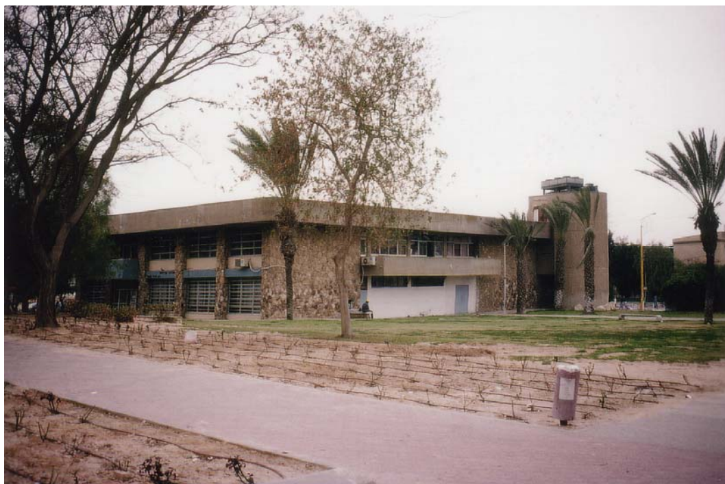
Abb.24: Das Kulturzentrum Dimonas
