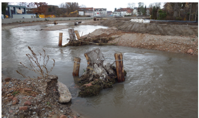
Eingebaute Wurzelstöcke im Kraichbach [RP Karlsruhe]
