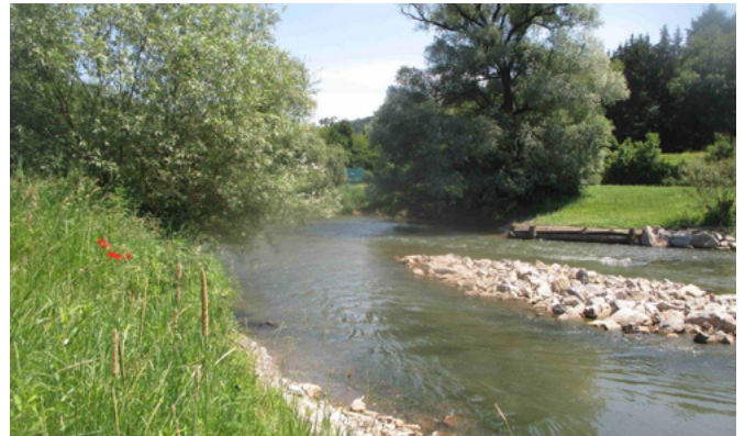
Durch Inselfschüttung initiierte Fließrinne im Neckar [Büro Heberle]
