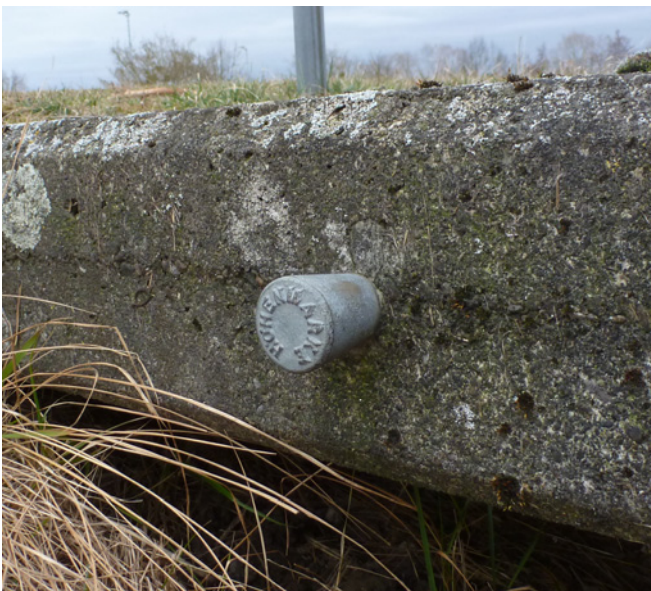
Bild 2: Höhenfestpunkt als Horizontalbolzen (Beispiel)
