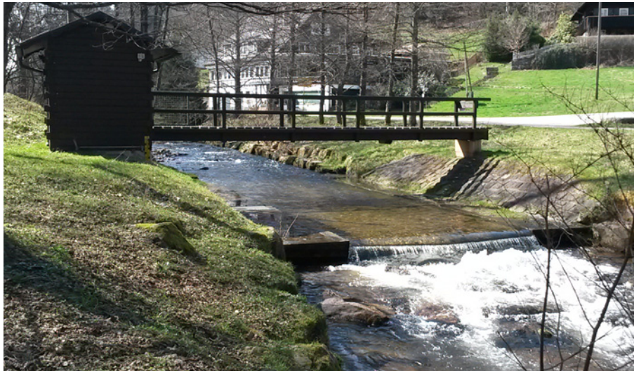
Bild 8: Eyachmühle-Eyach: Standort mit klassischer Schwelle (28.03.2017)
