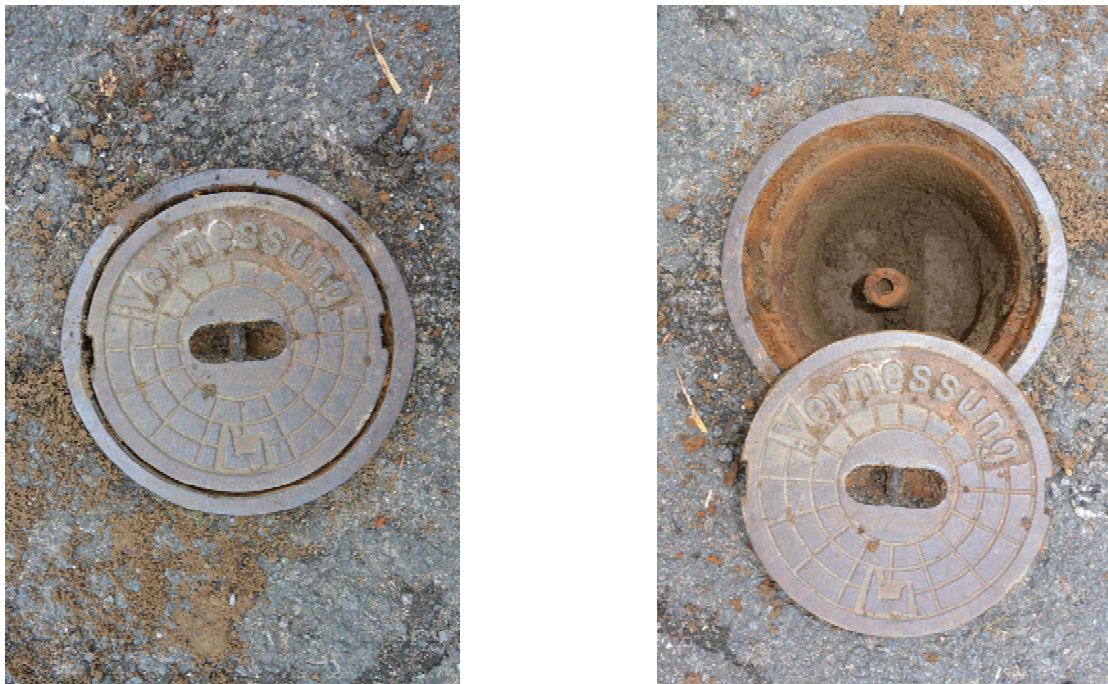
Bild 4: Beispiel für Lagefestpunkt (Aufnahmepunkt)
