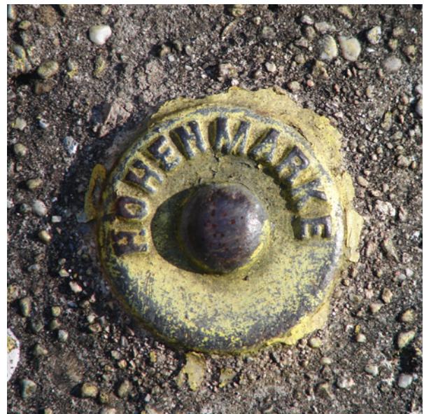
Bild 3: Höhenfestpunkt als Vertikalbolzen (Beispiel)
