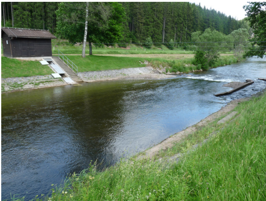
Bild 1: Hammereisenbach-Breg: Einschnürung, Seilkrananlage und Teilrampe (30.06.2016)
