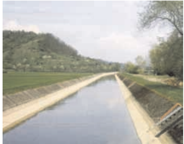
Abb. 64: Momentaner Zustand des alten Triebwasserkanals. Böschungen und Sohle bestehen aus Asphaltbeton. Die Querschnittsgeometrie ist trapezförmig.
