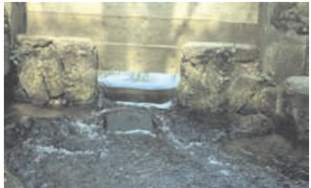
Abb. 15: Ausfluss aus einem Becken. Je weiter der Beckenwasserstand fällt, desto geringer wird auch die Fließgeschwindigkeit und der Wasserstand unterhalb des Auslaufes.
