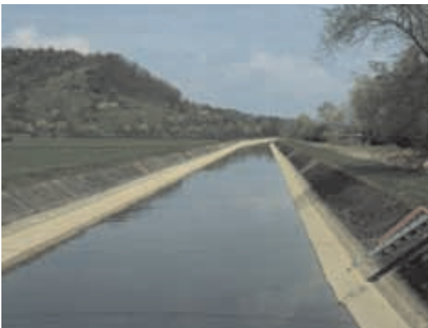
Abb. 13: Triebwerkskanal mit Trapezquerschnitt. Aufgrund der konstanten Gerinnegeometrie kann hier bei einer hydraulischen Berechnung von stationär-gleichförmigen Abflussbedingungen ausgegangen werden.
