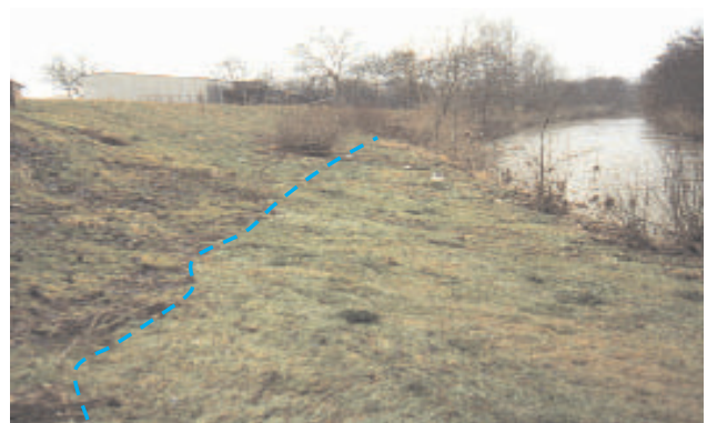
Abb. 29: Infolge eines kleinen Hochwassers wurde in den überströmten Vorlandbereichen das dort liegende Laub abgetragen.
