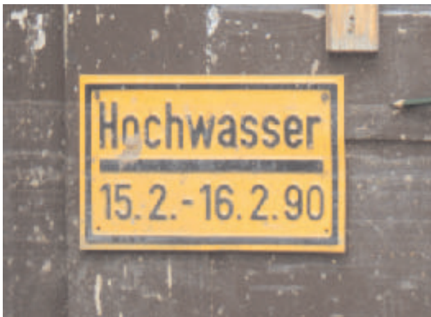
Abb.36: Hochwassermarke. Das Jahr des Hochwassers sollte jedoch vollständig angegeben werden (1990).
