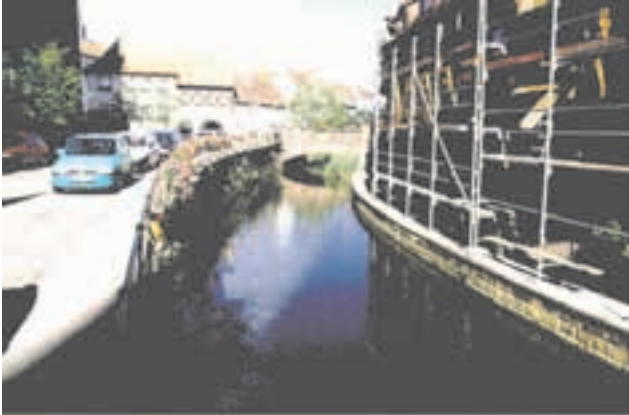
Abb. 72: Der Bach in der Ortslage mit kastenförmigem künstlichem Gewässerbett.
