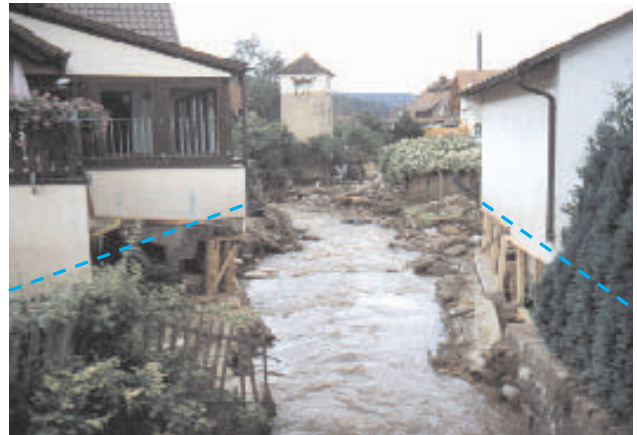
Abb. 32: Infolge einer massiven Gewässereinengung durch Bebauung der Uferzonen kam es in diesem Fall bei einem extremen Hochwasser zu schweren Zerstörungen der angrenzenden Gebäude durch die hohen Strömungskräfte.
