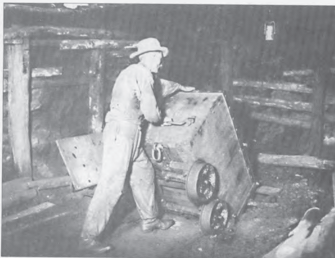
Abkippen des Eisensteins in eine Rolle (zur Sicherheit sind zwei Hölzer über die Rollenöffnung gelegt)
