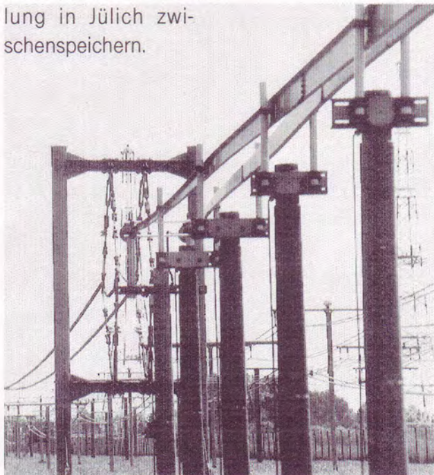
Symmetrier- und Transformationsleitung
