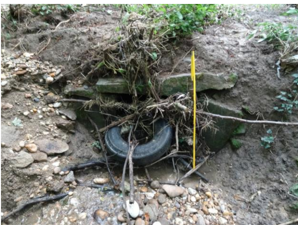
Abbildung 96: Verlegter Durchlass Pilotgebiet Schwertberg nach Oberflächenabflussereignis
